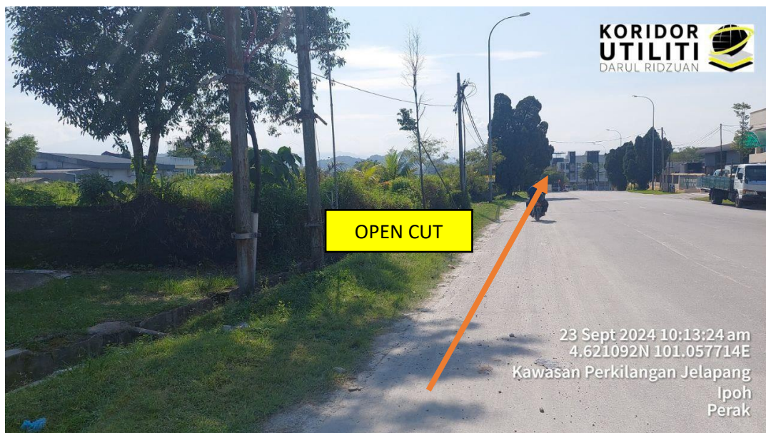
KOREKAN TERBUKA SEPANJANG 146 METER
