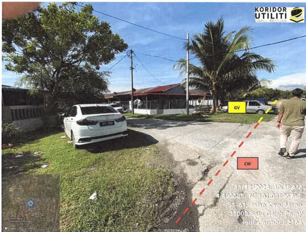
JAJARAN KOREKAN TERBUKA DAN CROSSING 2 DI JALAN MERANTI – JALAN KAYU MANIS
