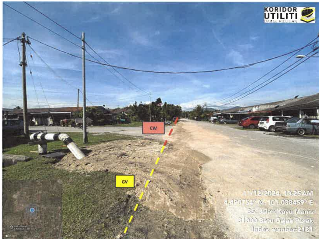
JAJARAN KOREKAN TERBUKA DAN CROSSING 3 DI JALAN TEMPINIS – JALAN KAYU MANIS (Turapan semula akan dilakukan bagi keseluruhan jalan bermula daripada penghujung Jalan Tempinis hingga ke Jalan Kayu Manis)
