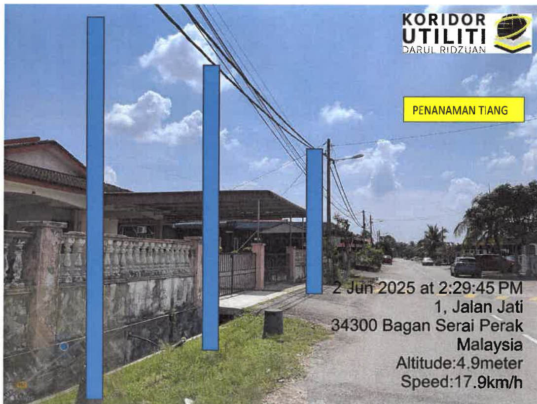
LOKASI DI JALAN TAMAN SERAI JATI
