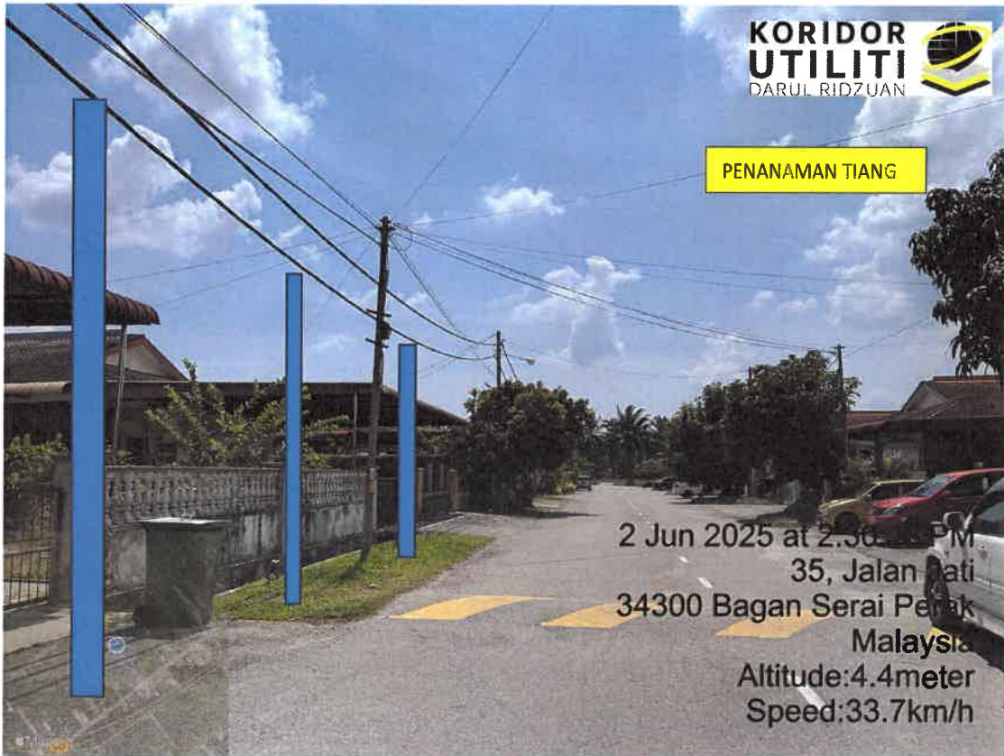
LOKASI DI JALAN TAMAN SERAI JATI
