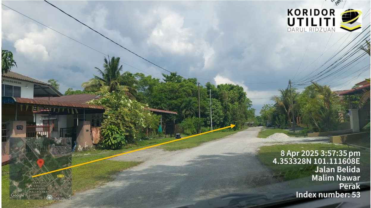
JAJARAN PEMASANGAN TIANG
