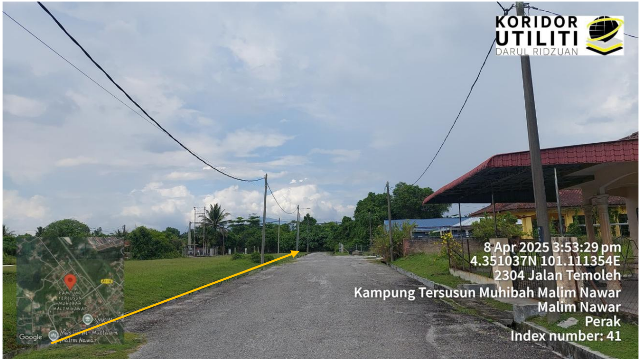
JAJARAN PEMASANGAN TIANG
