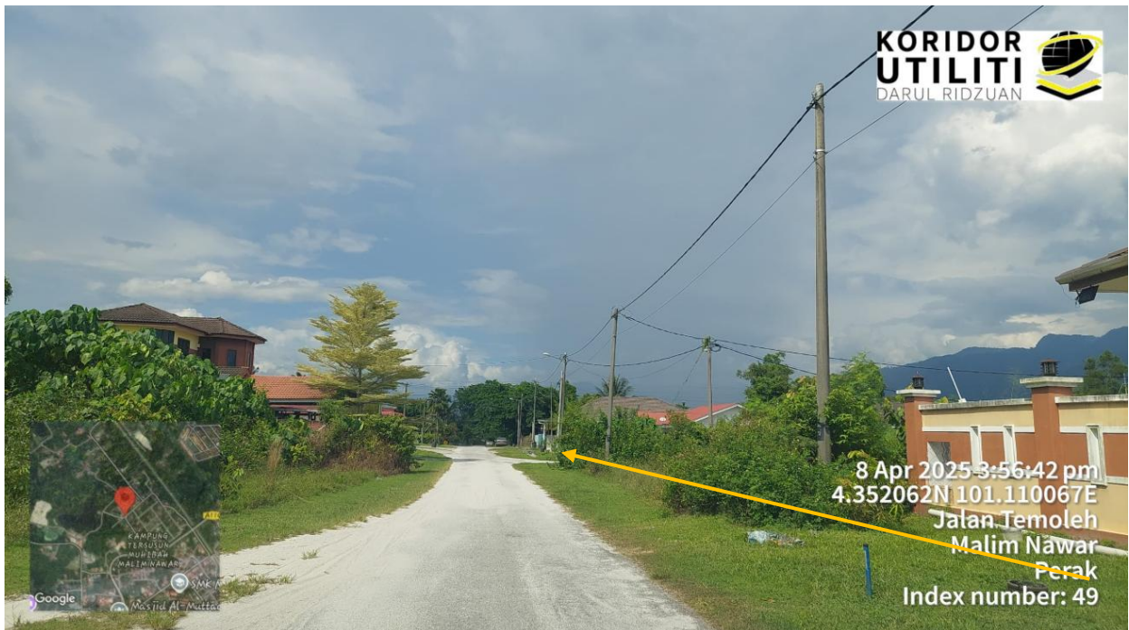
JAJARAN PEMASANGAN TIANG
