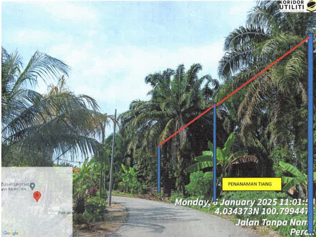
LOKASI DI JALAN HJ SARBANI 1
