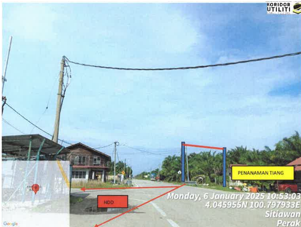
LOKASI DI JALAN KAMPUNG KAYAN A228
