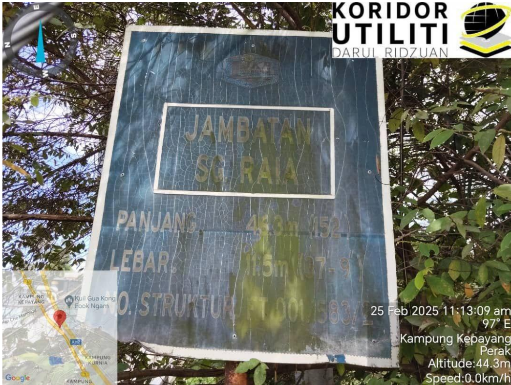
JAJARAN KERJA HDD DI SUNGAI RAJA (Akan bersambung ke Existing Manhole 2)
