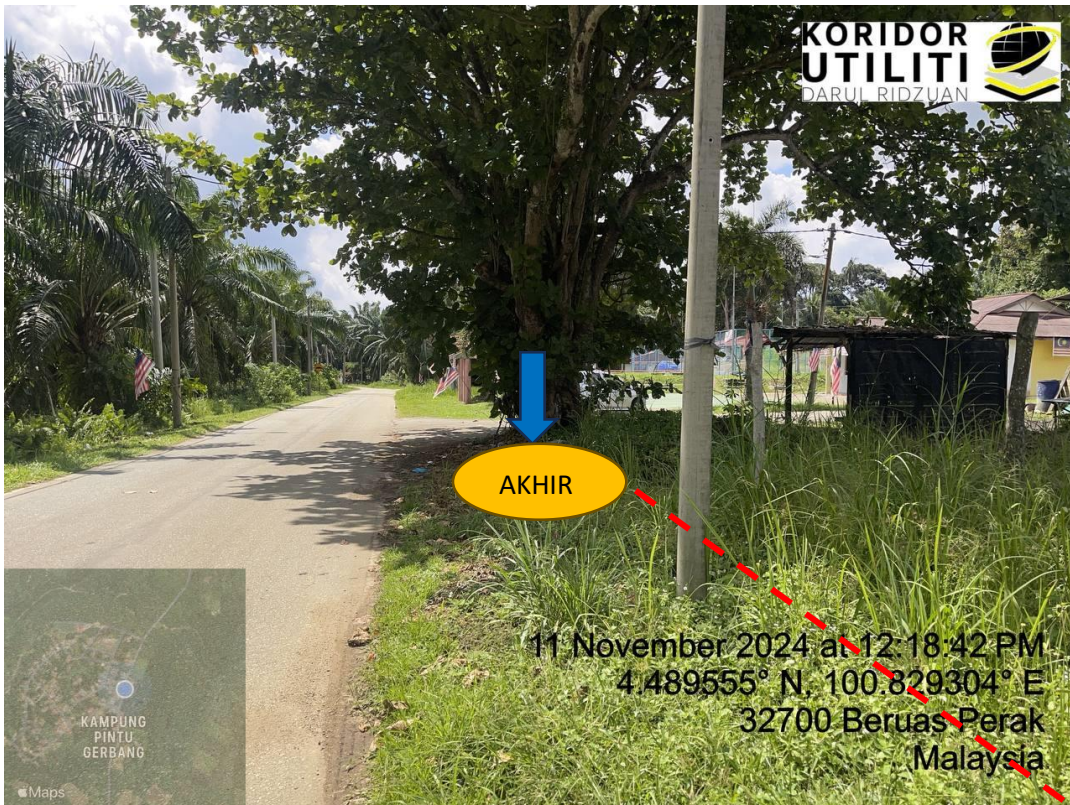
LOKASI DI JALAN KAMPUNG PINTU GERBANG
