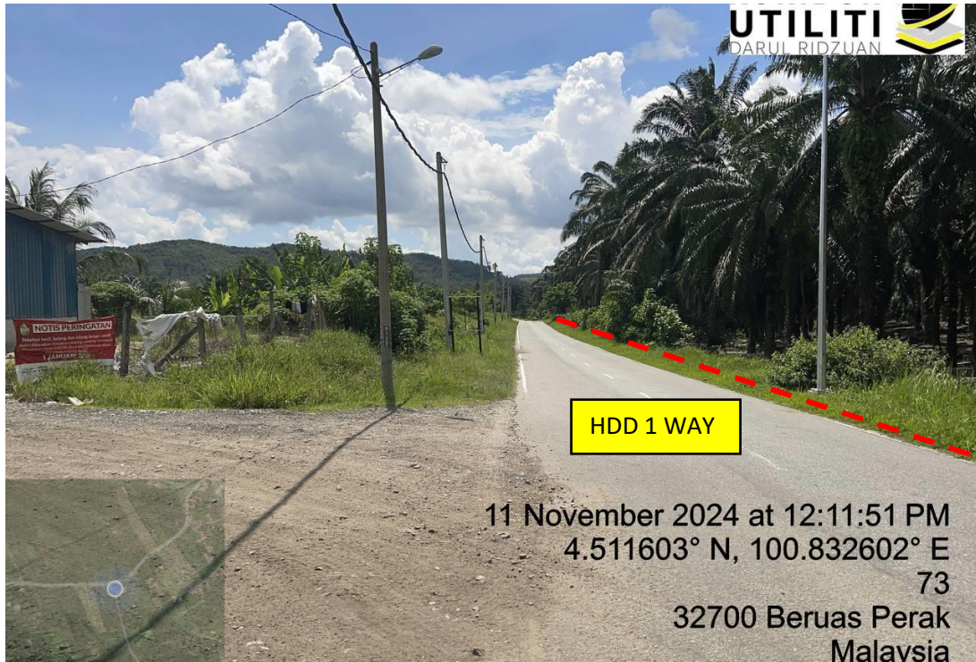
LOKASI DI JALAN KAMPUNG PINTU GERBANG
