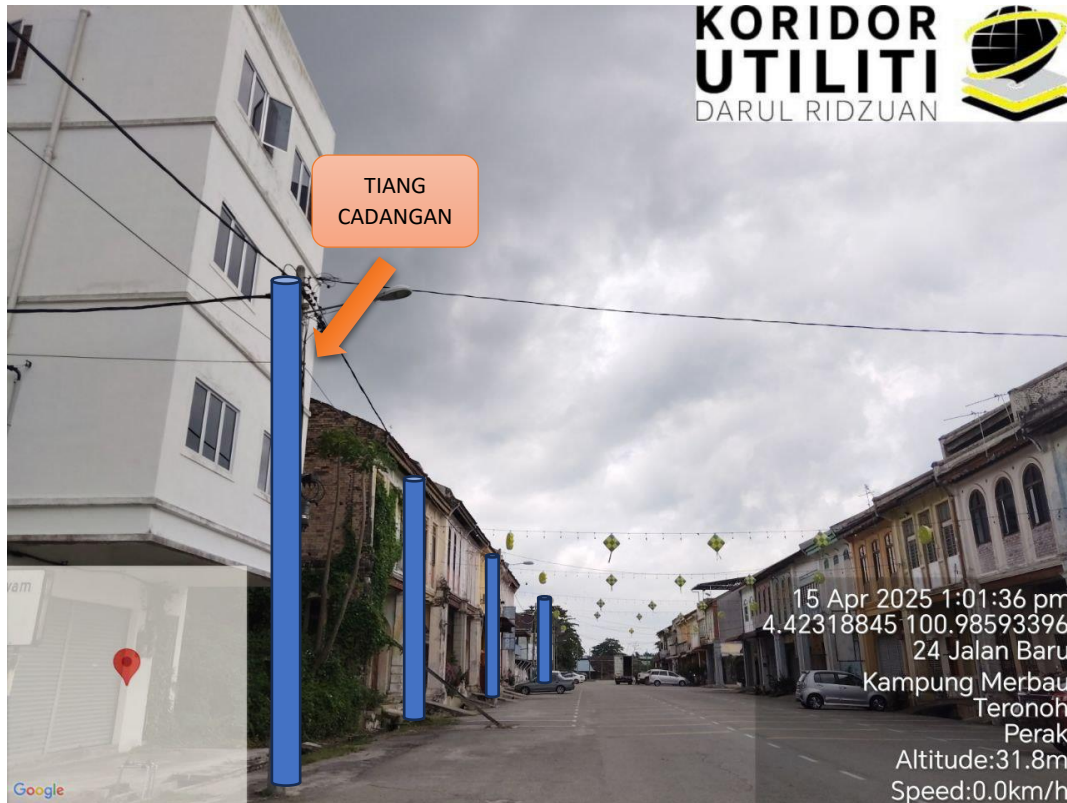
LOKASI DI JALAN BARU
