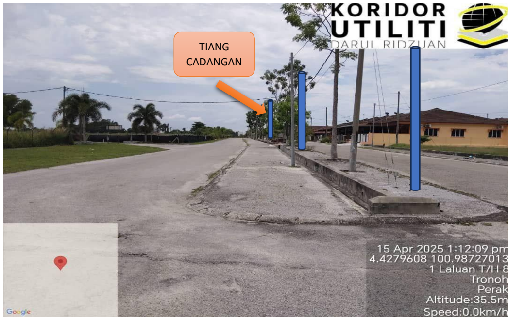
LOKASI DI JALAN BOTA LAMA
