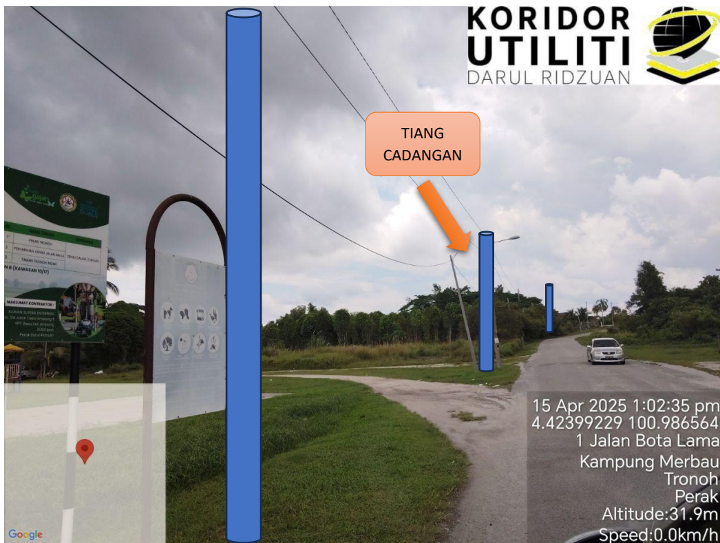
LOKASI DI JALAN BOTA LAMA
