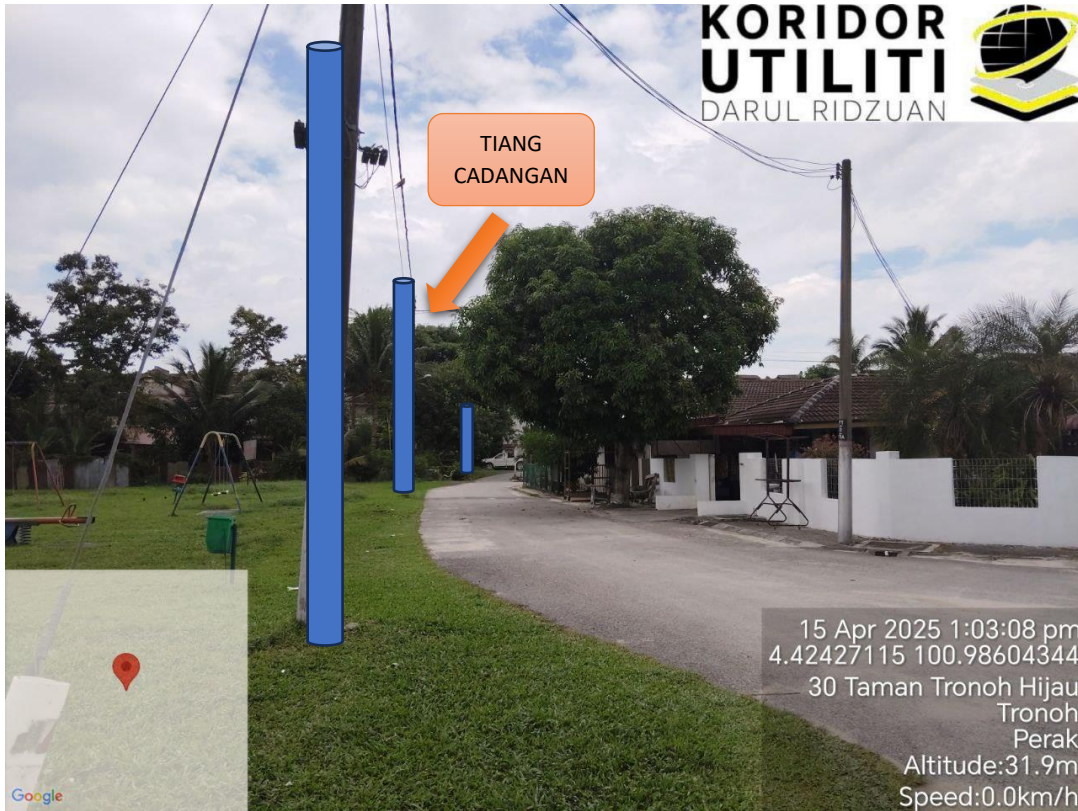
LOKASI DI JALAN TAMAN TRONOH HIJAU
