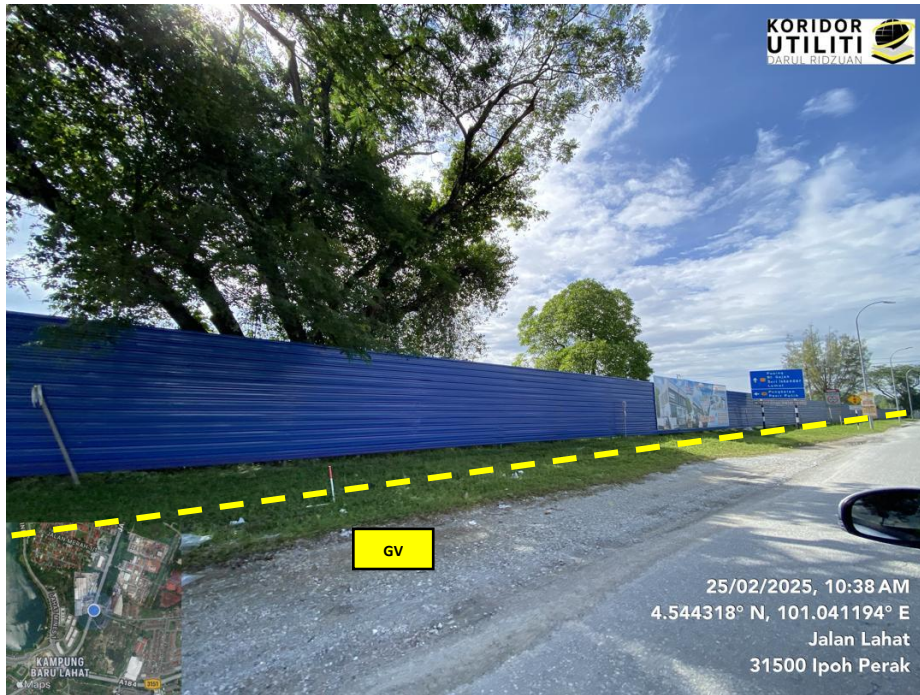
JAJARAN KOREKAN TERBUKA JALAN TIDAK BERTURAP DI JALAN LAHAT – PUSING (A2) (Jalan milik JKR)
