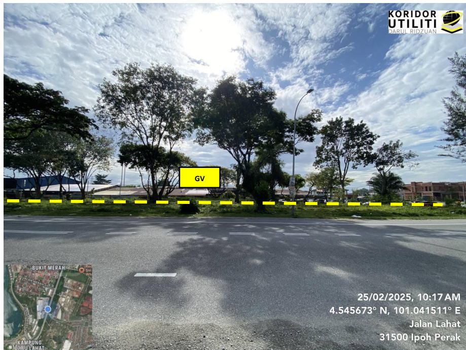
JAJARAN KOREKAN TERBUKA JALAN TIDAK BERTURAP DI JALAN LAHAT (JALAN MILIK MBI)
