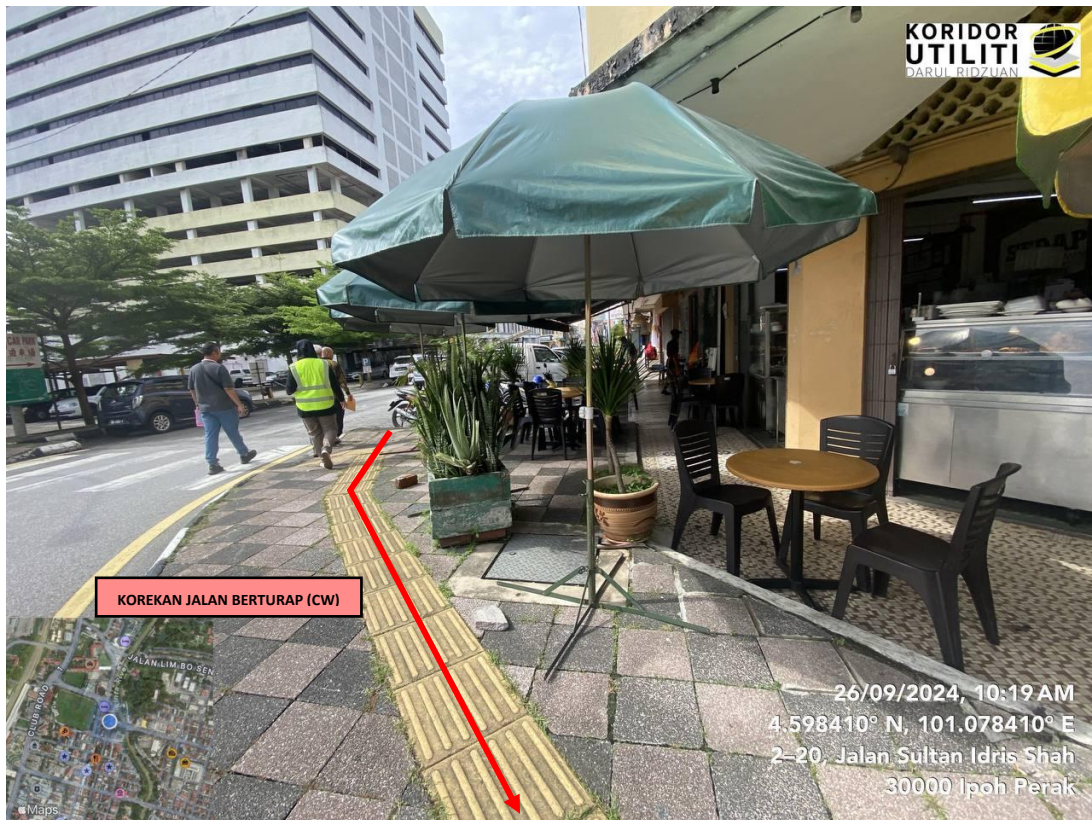
Laluan korekan jalan berturap (CW) di Jalan Sultan Idris Shah
