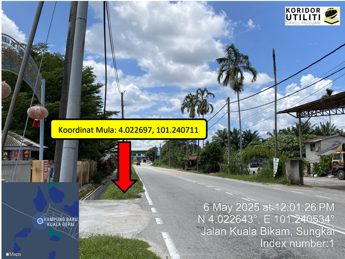
JALAN KUALA BIKAM – SUNGKAI
