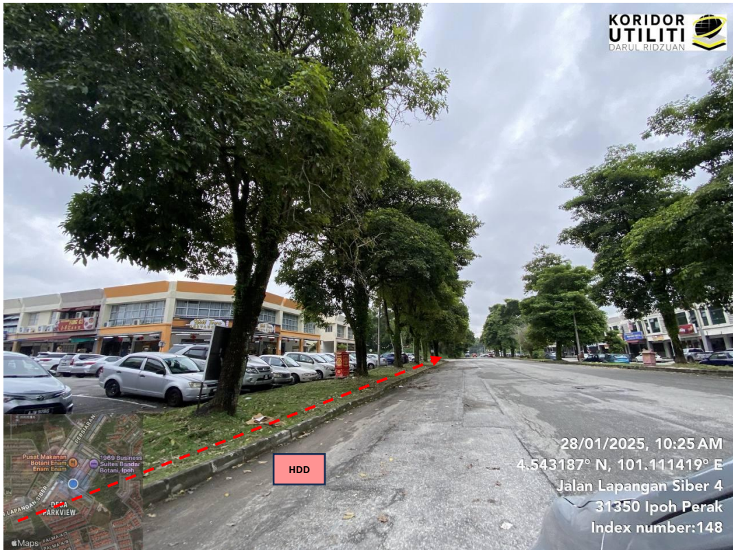
JAJARAN KERJA HDD DI JALAN LAPANGAN SIBER 4
