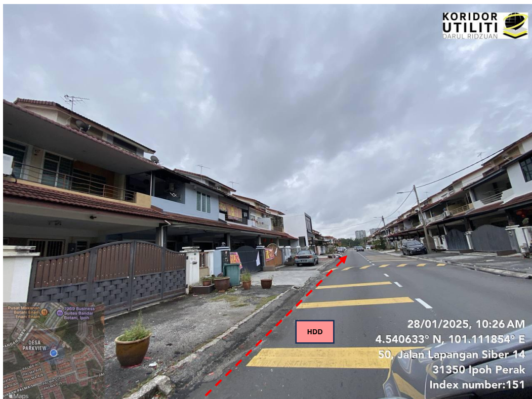
JAJARAN KERJA HDD DI JALAN LAPANGAN SIBER 14
