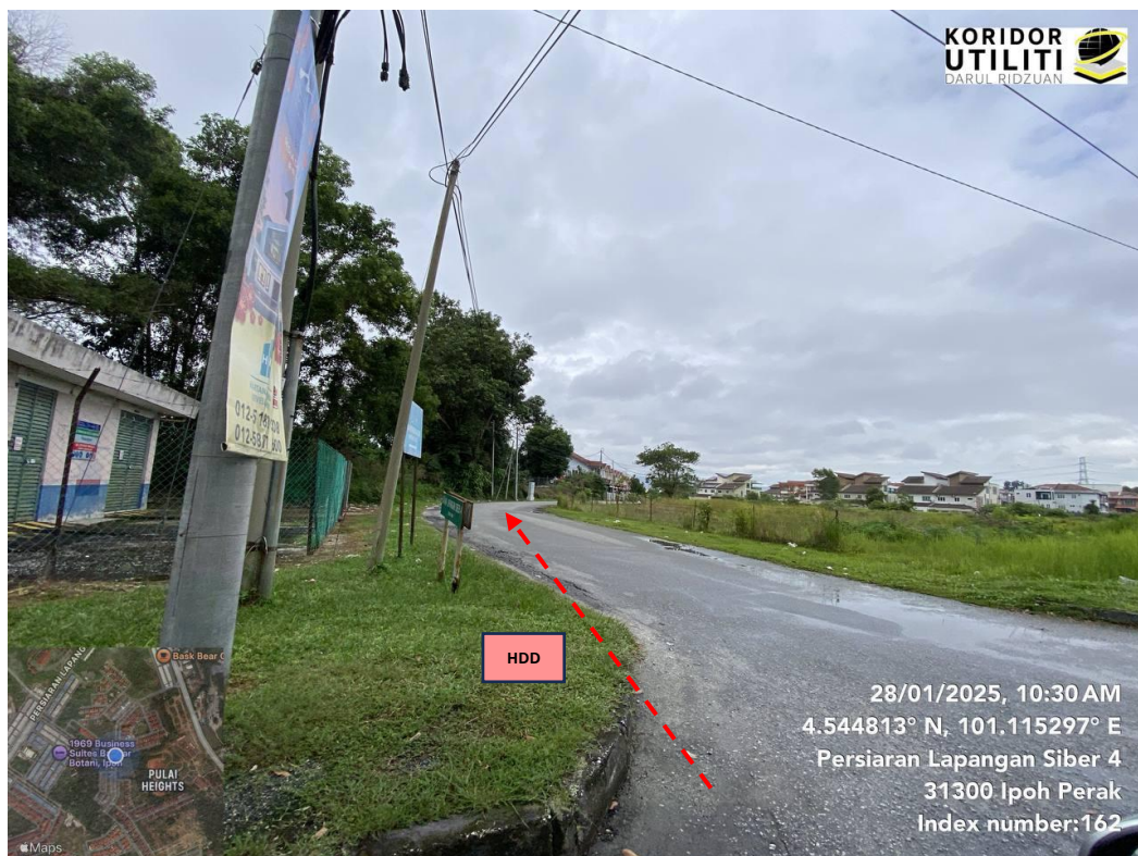
JAJARAN KERJA HDD DI JALAN HAJI BUYONG SILIN
