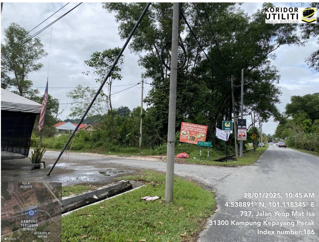
JAJARAN KERJA HDD DI PERSIARAN SENGAT BARU 18
