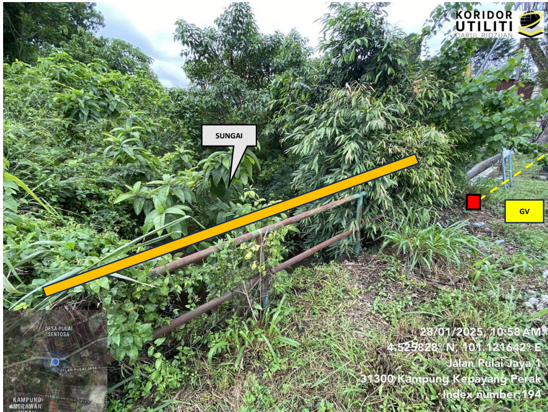
AJARAN KERJA DI JALAN PULAI JAYA 1 (Crossing Sungai: Tambatan kabel akan dibuat menggunakan kaedah GI)
