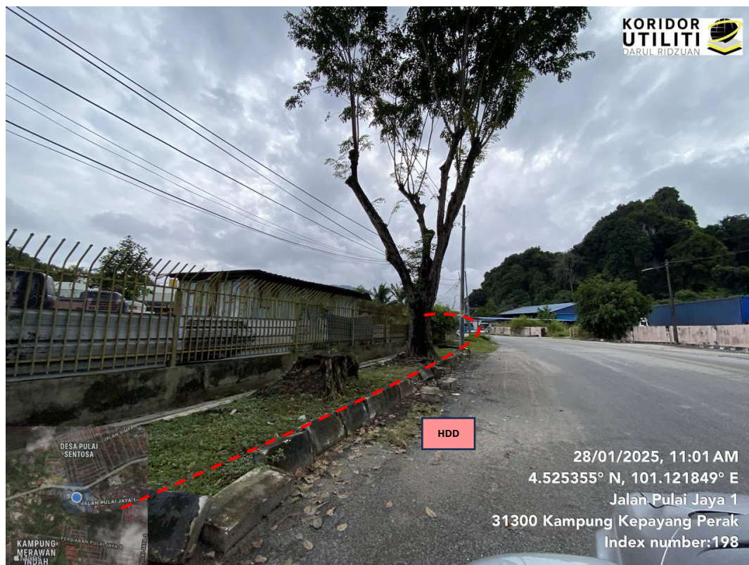
AJARAN KERJA HDD DI JALAN PULAI JAYA 1
