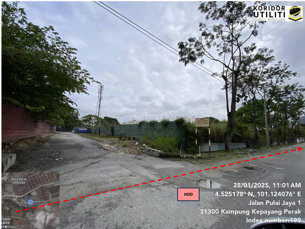
JAJARAN KERJA HDD DI JALAN PULAI JAYA 1
