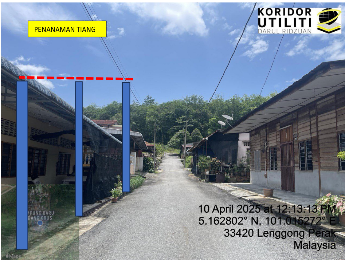
LOKASI DI JALAN KAMPUNG BARU PADANG GRUS
