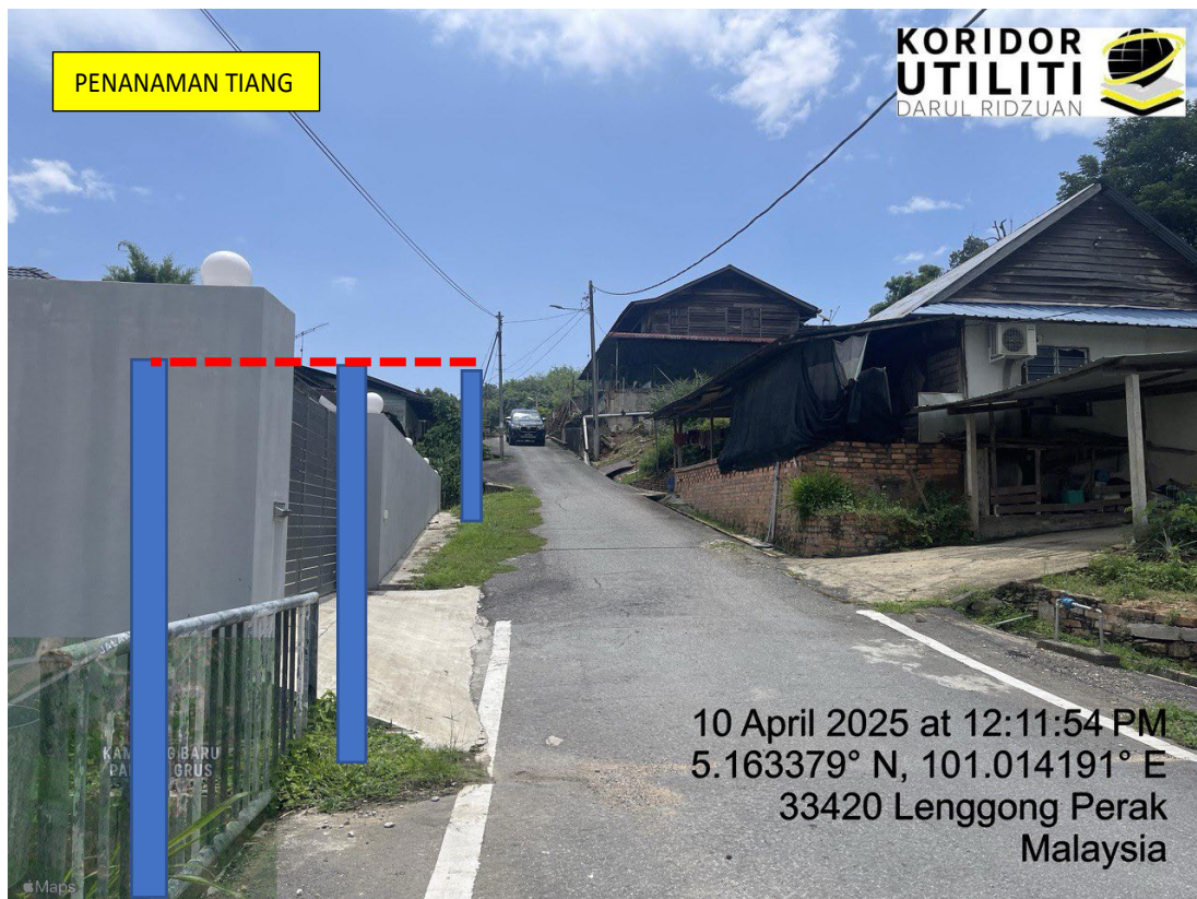
LOKASI DI JALAN KAMPUNG BARU PADANG GRUS
