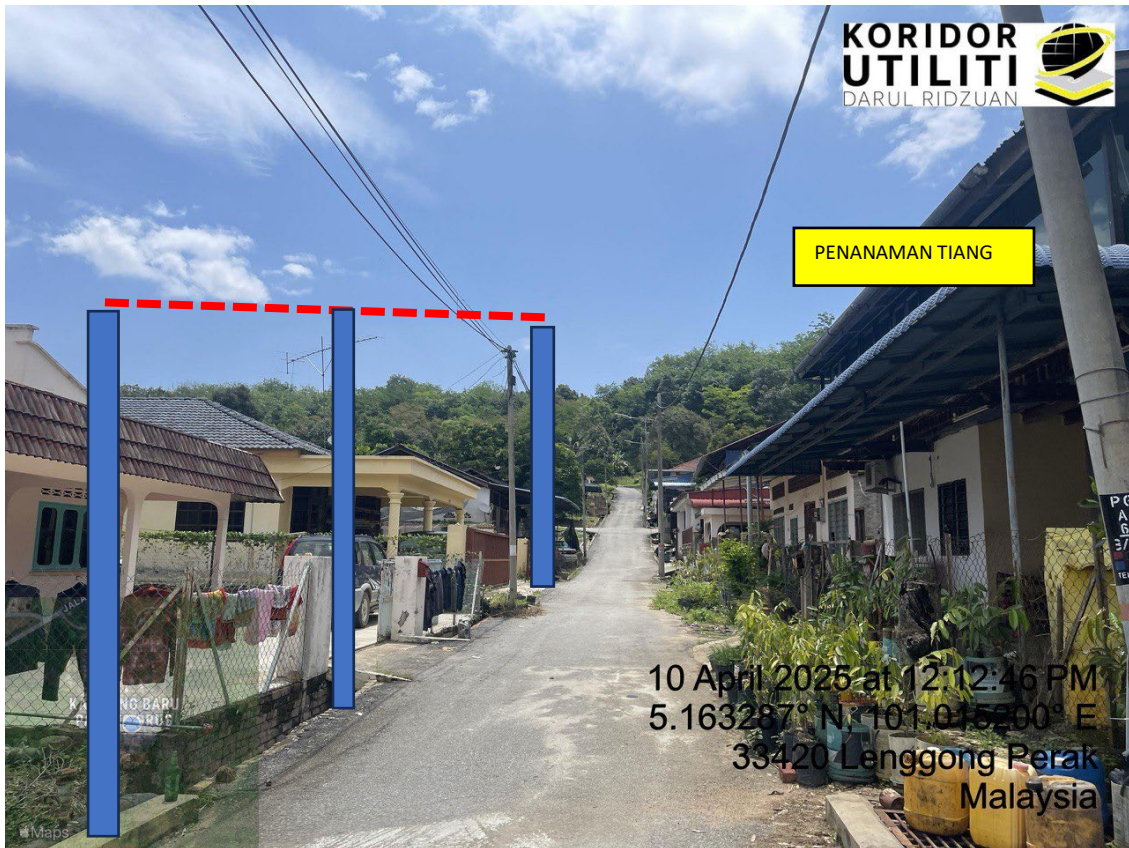
LOKASI DI JALAN KAMPUNG BARU PADANG GRUS
