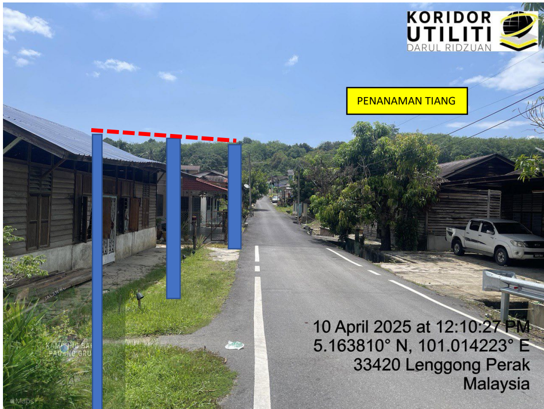
LOKASI DI JALAN KAMPUNG BARU PADANG GRUS
