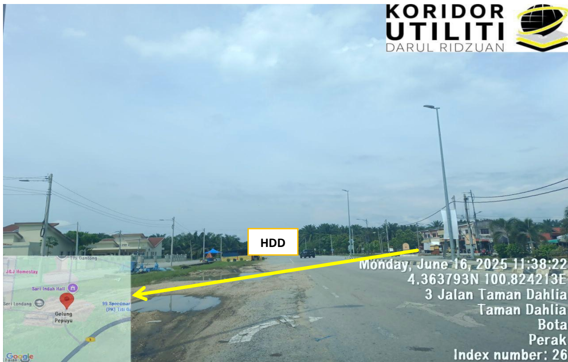
LOKASI KERJA DI JALAN GELUNG PEPUYU (A127)
