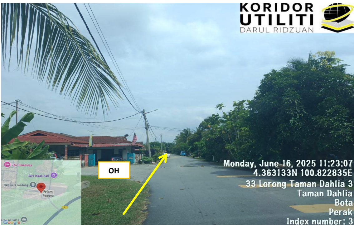
CADANGAN LALUAN BAGI KERJA PENANAMAN TIANG
