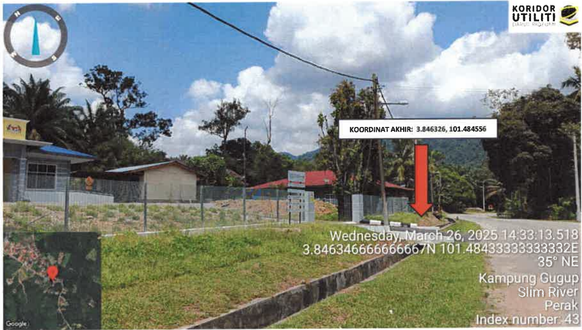
Rajah 32: Lokasi Koordinat Akhir Jalan Slim
