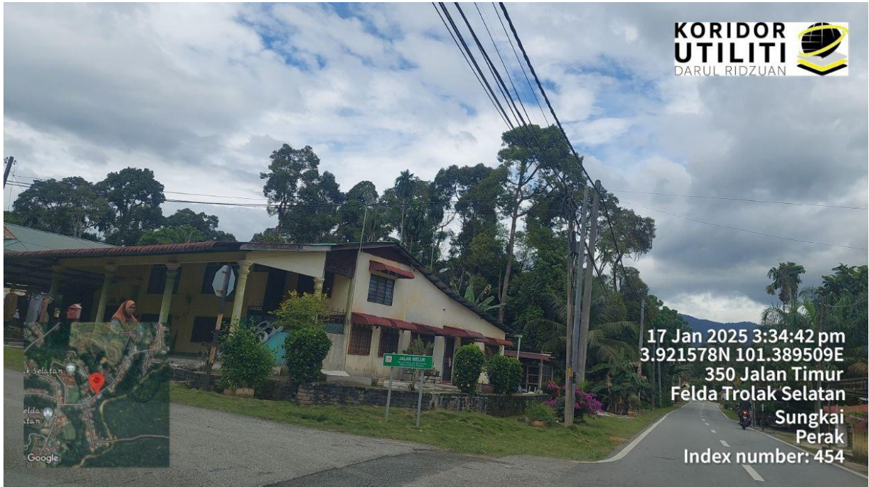
CADANGAN UNTUK PEMASANGAN TIANG 9METER DI KAWASAN CROSSING
