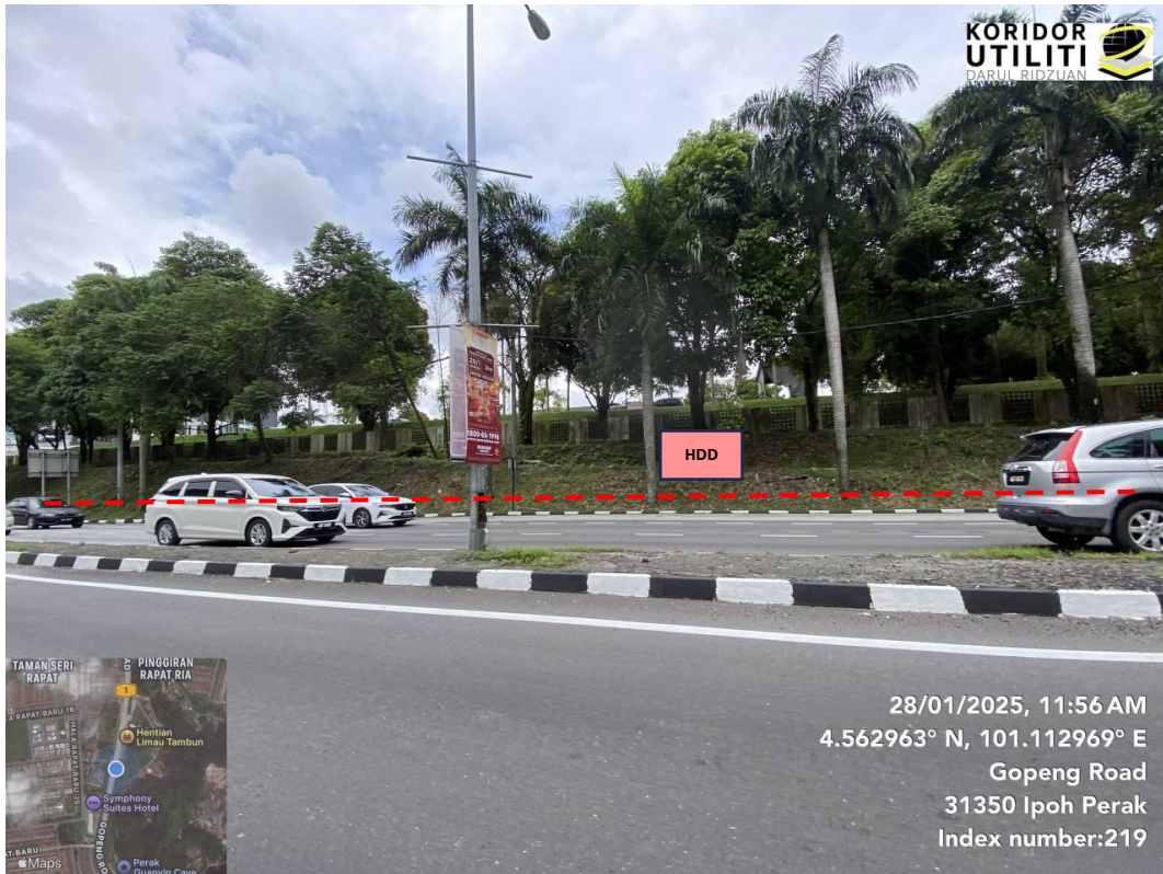
JAJARAN KERJA HDD DI JALAN IPOH – TANJUNG MALIM (FT01)
