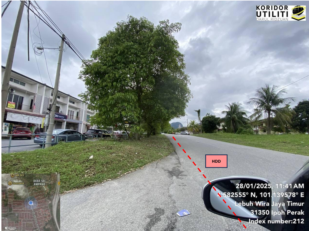
JAJARAN KERJA HDD DI JALAN WIRA JAYA
