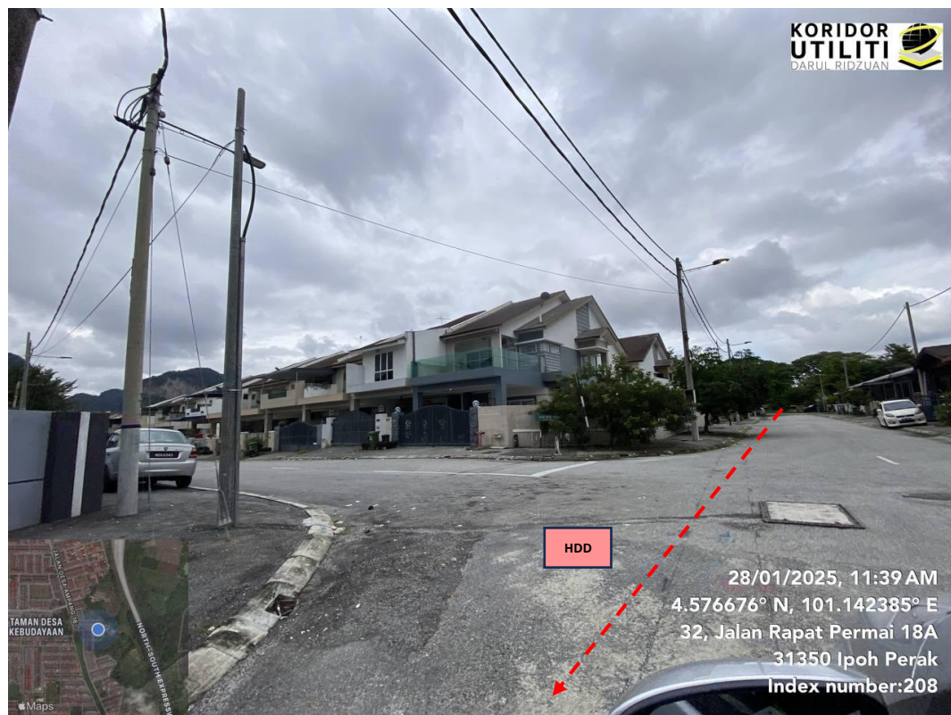
JAJARAN KERJA HDD DI JALAN RAPAT PERMAI 18A
