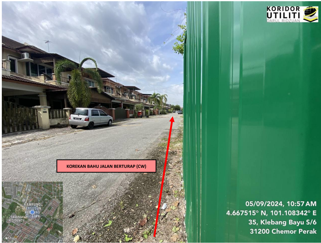
LALUAN KOREKAN TERBUKA DI KLEBANG BAYU S/6
