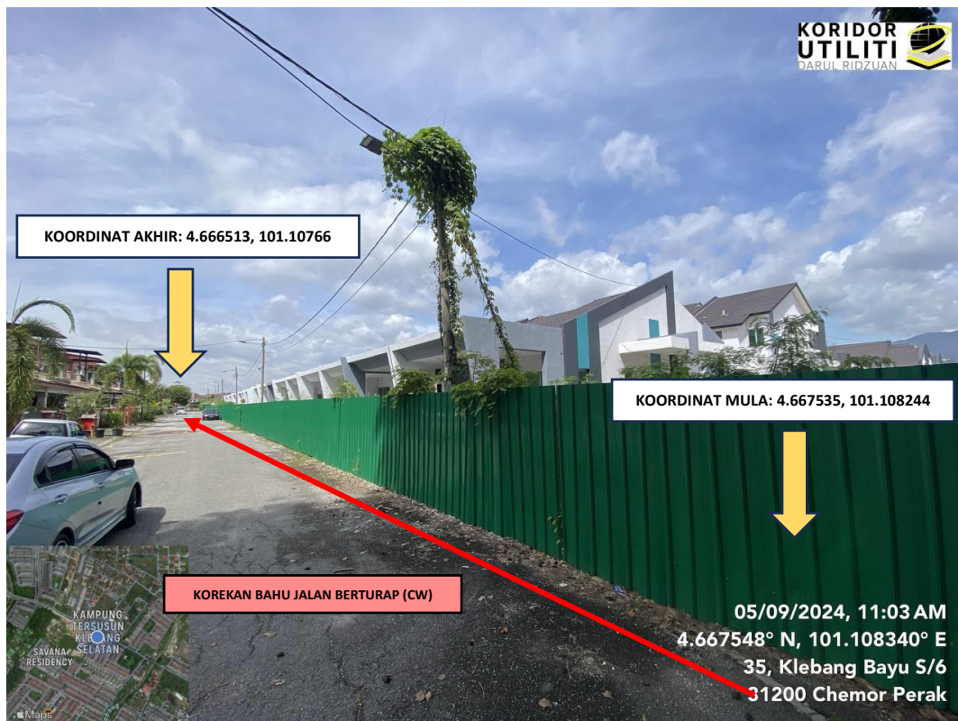
LALUAN KOREKAN TERBUKA DI KLEBANG BAYU S/6
