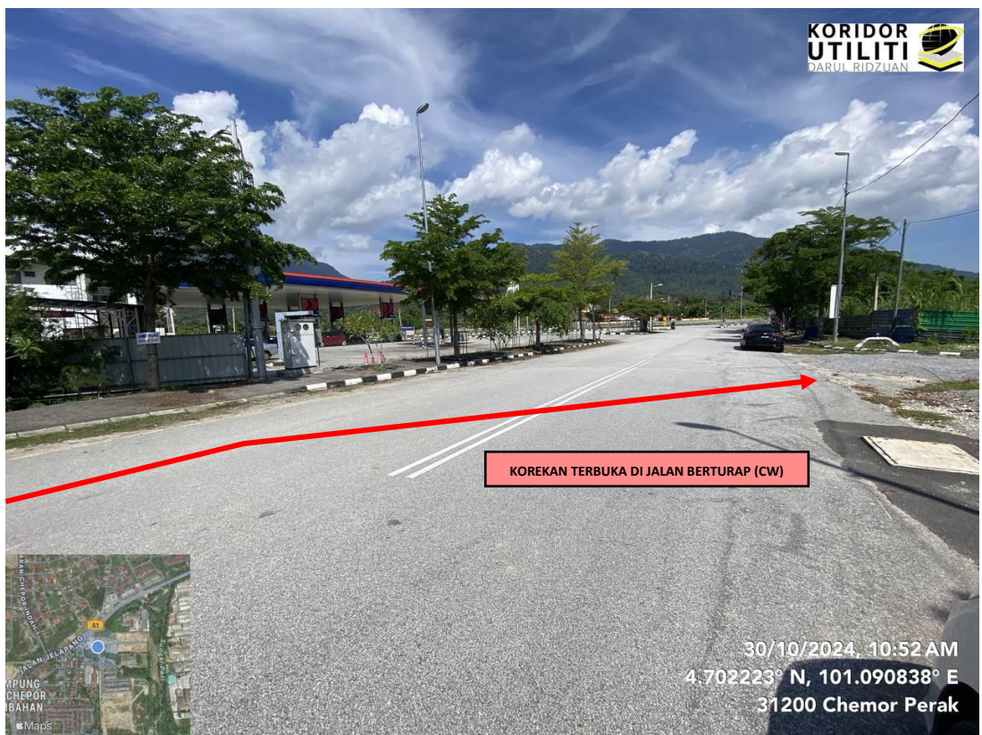
JAJARAN KOREKAN TERBUKA JALAN BERTURAP DI LEBUH CHEPOR (CROSSING)
