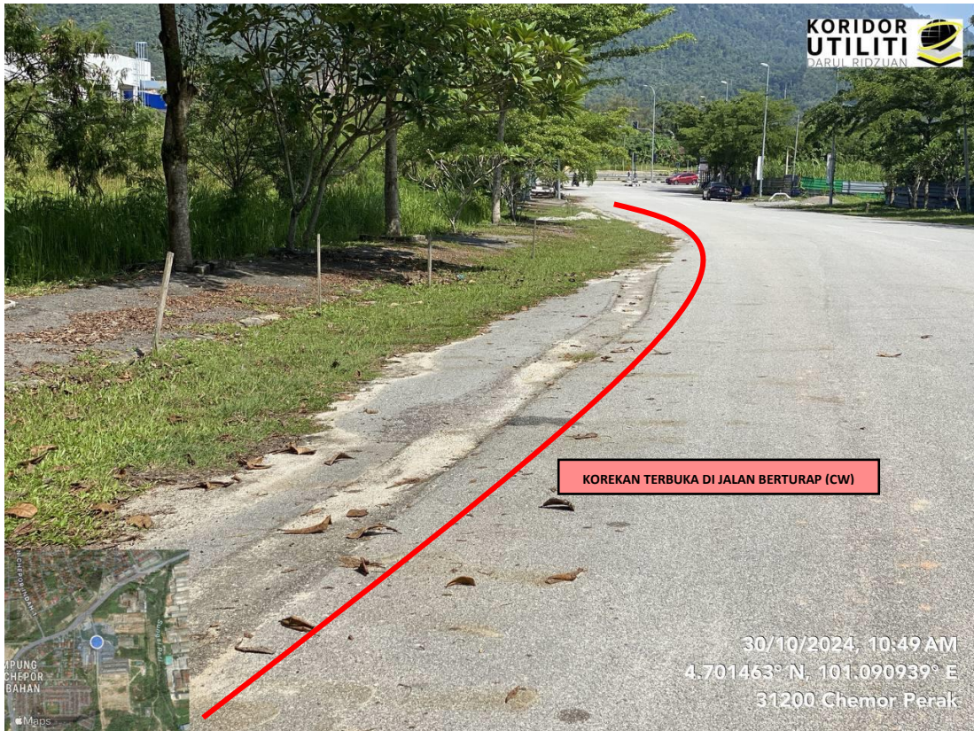
JAJARAN KOREKAN TERBUKA JALAN BERTURAP DI LEBUH CHEPOR
