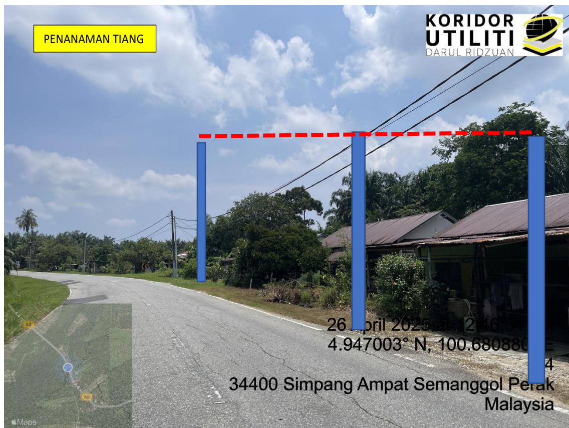
LOKASI DI JALAN KERIAN
