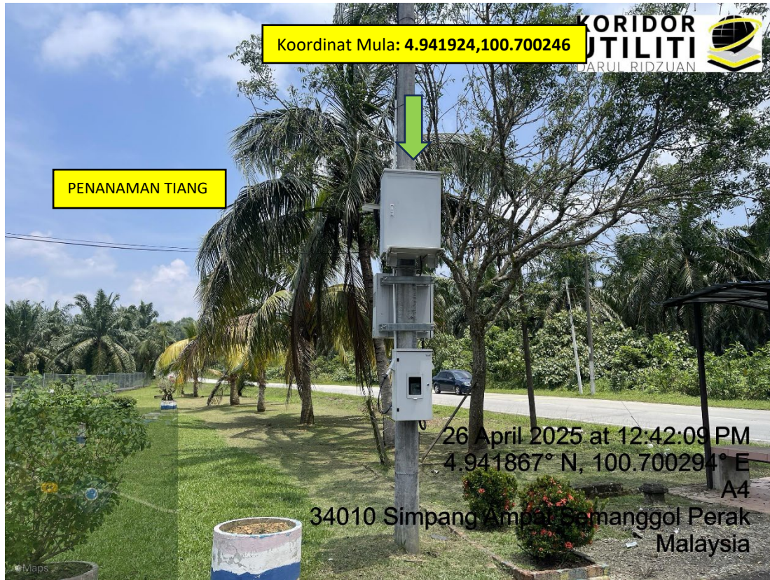
LOKASI DI JALAN KERIAN
