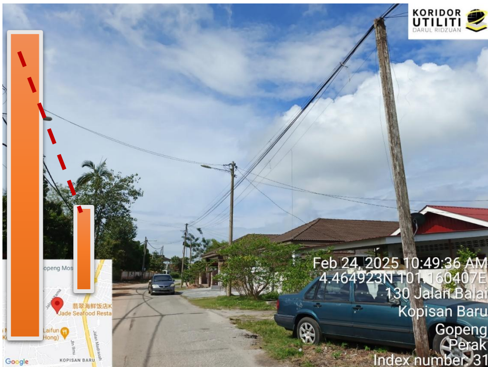
LOKASI DI LORONG BALAI, PENANAMAN TIANG
