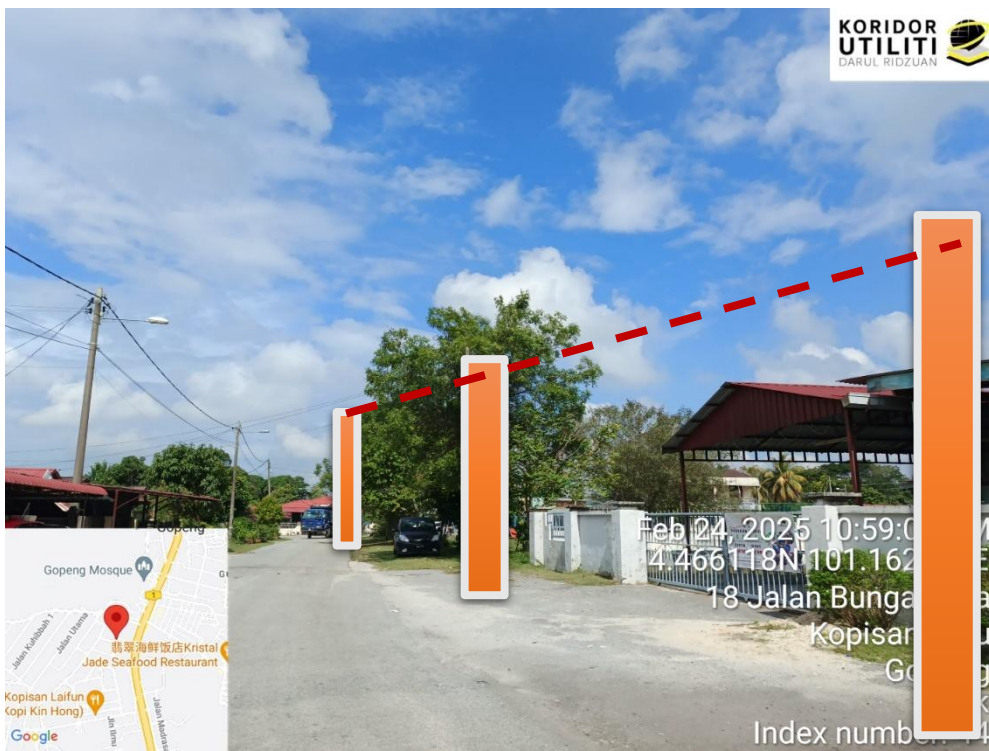
LOKASI DI JALAN BUNGA RAYA, PENANAMAN TIANG
