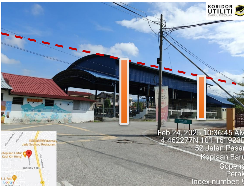
LOKASI DI JALAN ILMU, PENANAMAN TIANG
