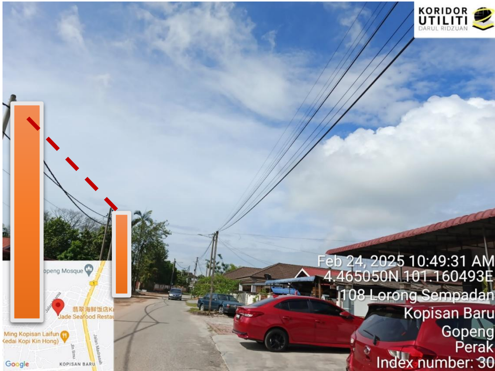
LOKASI DI LORONG BALAI, PENANAMAN TIANG
