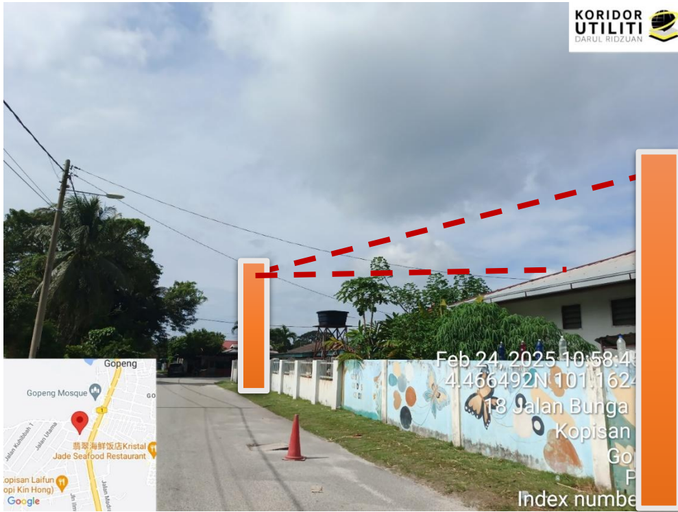
LOKASI DI JALAN BUNGA RAYA, PENANAMAN TIANG
