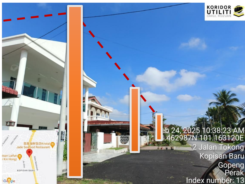
LOKASI DI JALAN TOKONG, PENANAMAN TIANG
