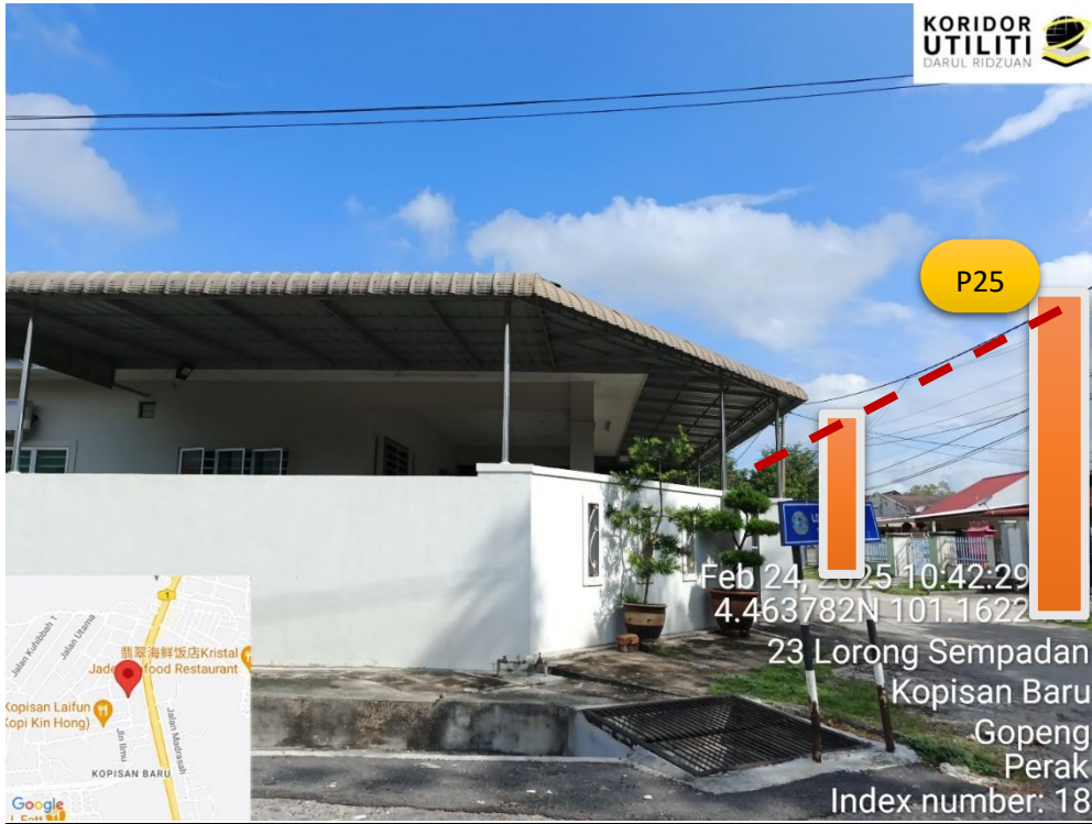
LOKASI DI LORONG PASAR, PENANAMAN TIANG
