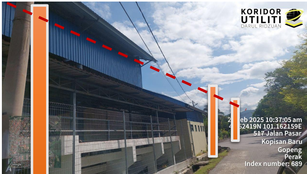
LOKASI DI JALAN SEKOLAH, PENANAMAN TIANG
