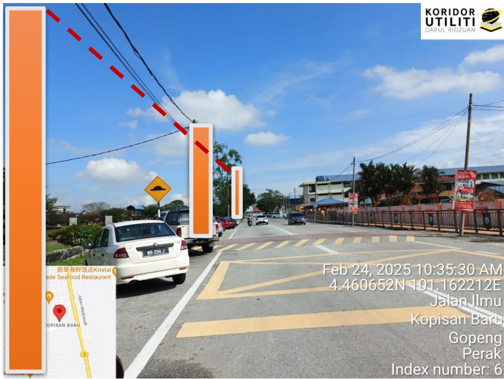
LOKASI DI JALAN ILMU, PENANAMAN TIANG
