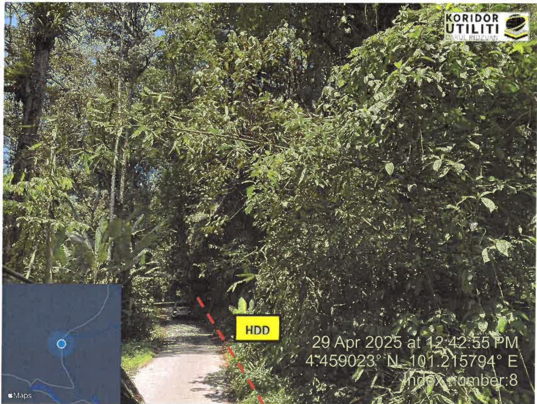
JAJARAN PEMASANGAN UTILITI
