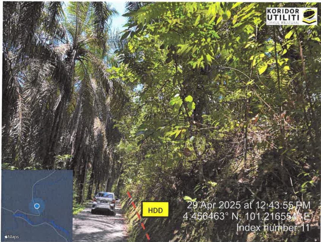
JAJARAN PEMASANGAN UTILITI
