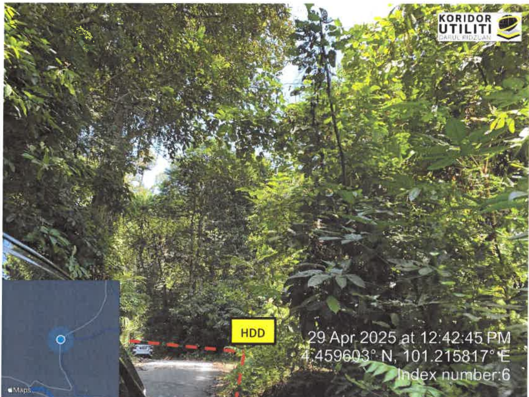
JAJARAN PEMASANGAN UTILITI
