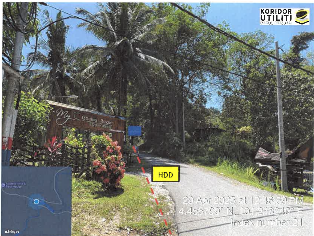
JAJARAN PEMASANGAN UTILITI
