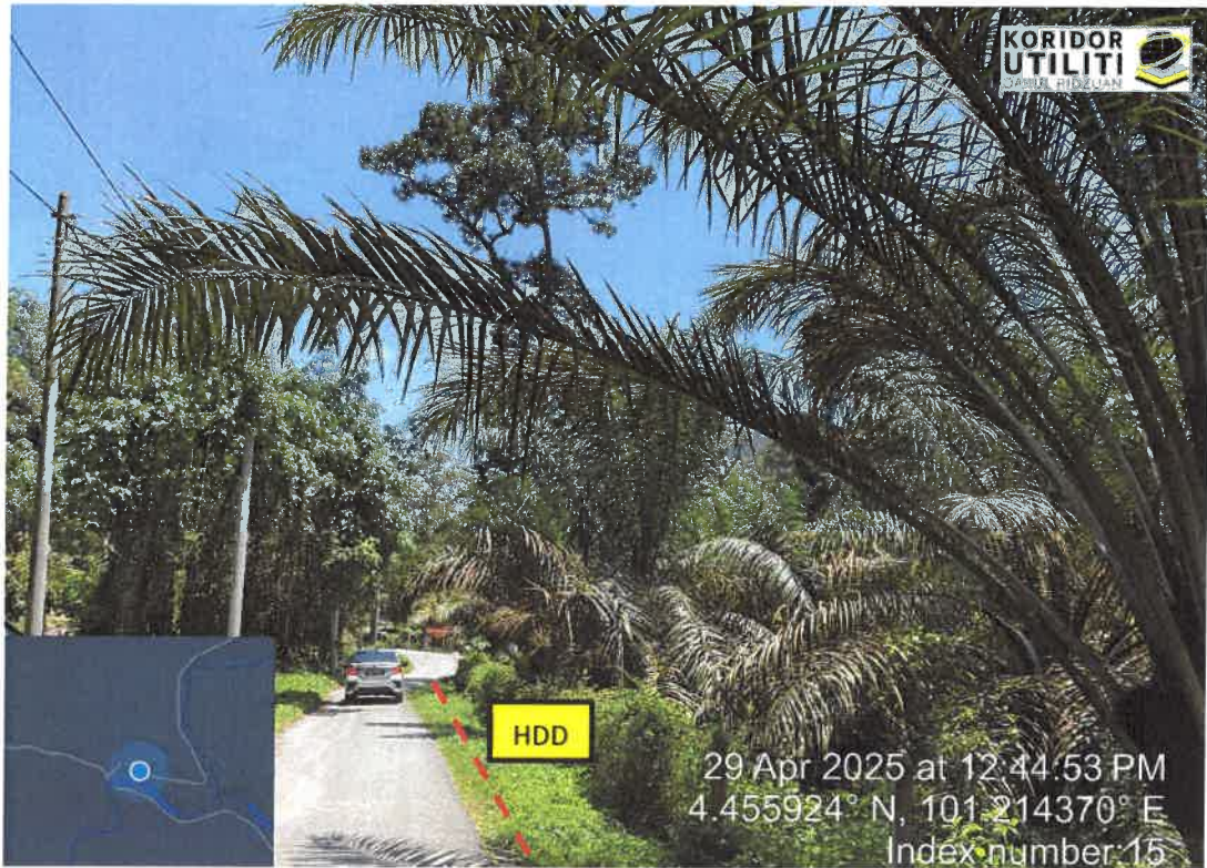
JAJARAN PEMASANGAN UTILITI
