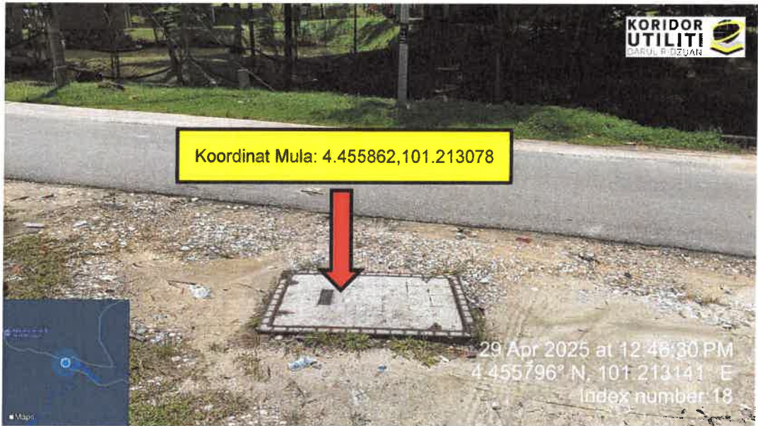
JALAN KAMPUNG PINTU PADANG
