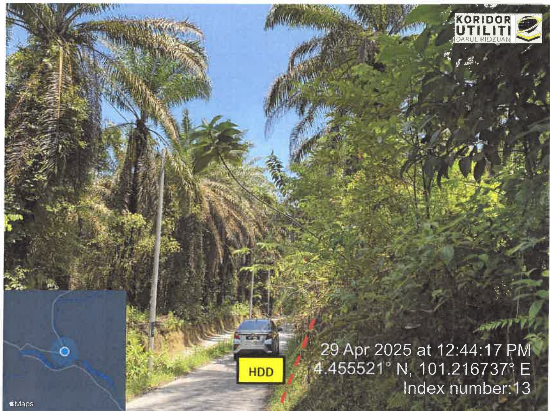
JAJARAN PEMASANGAN UTILITI
