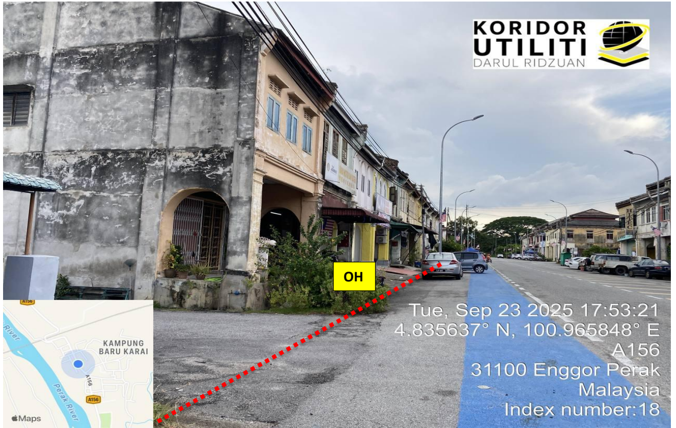
LOKASI DI JALAN KARAI JAWANG TROSOR (A156)
