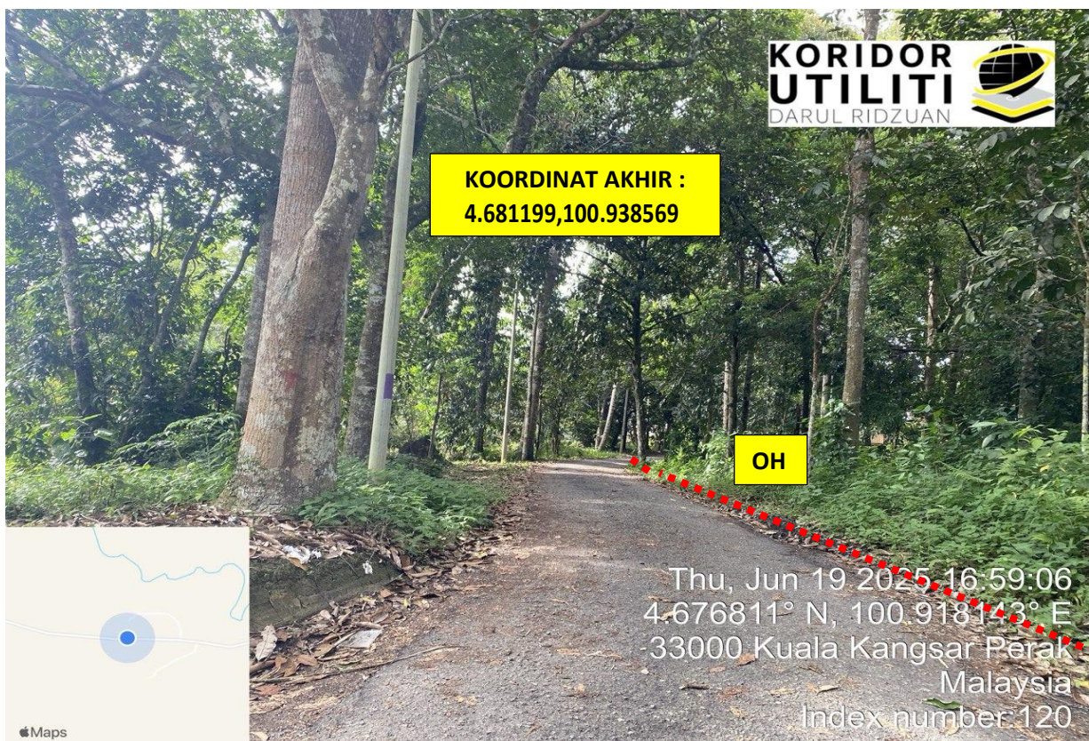
LOKASI DI JAJARAN PEMASANGAN UTILITI
