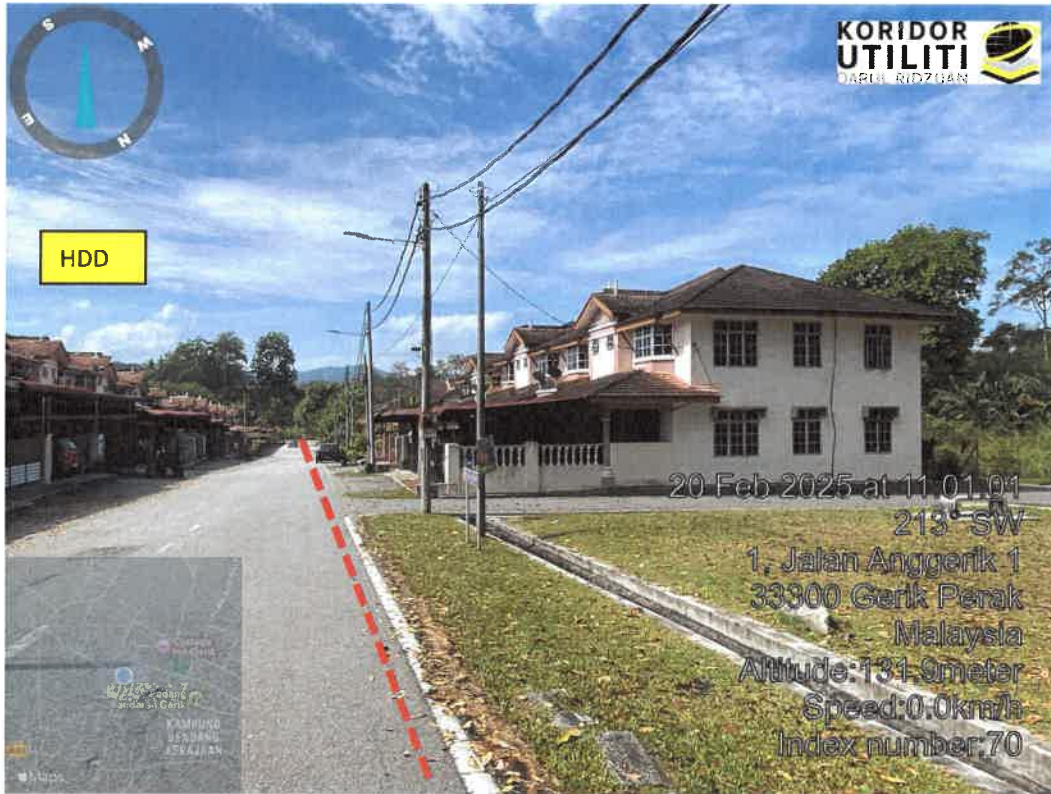
LOKASI DI JALAN ANGERIK 1
