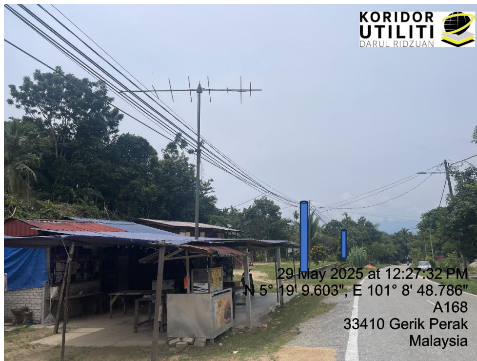
LOKASI DI JALAN DANDA TEMENGGOR
