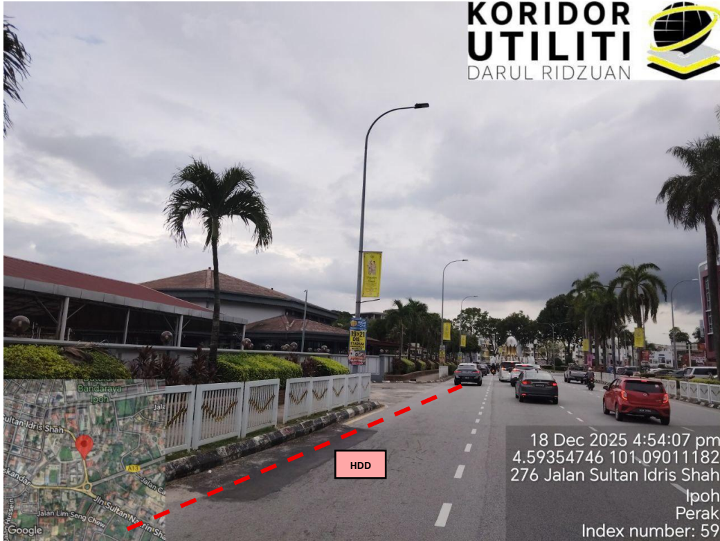
JAJARAN KERJA HDD DI JALAN SULTAN IDRIS SHAH
