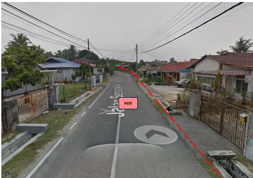
JAJARAN HDD DI JALAN SEMARAK API (Sambungan akan dibuat daripada PPU TYRONE ke P/E TAMAN CHENDERONG JAYA)
