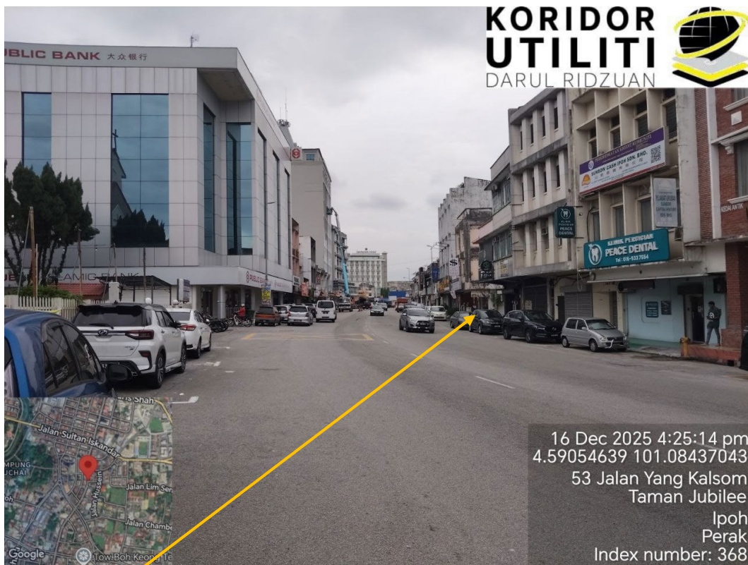
JAJARAN PEMASANGAN UTILITI – KERJA HDD
