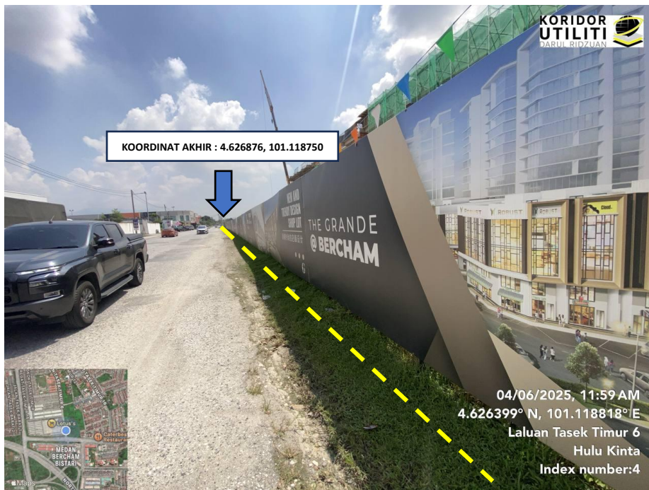
JAJARAN KOREKAN TERBUKA JALAN TIDAK BERTURAP DI LALUAN TASEK TIMUR 6
