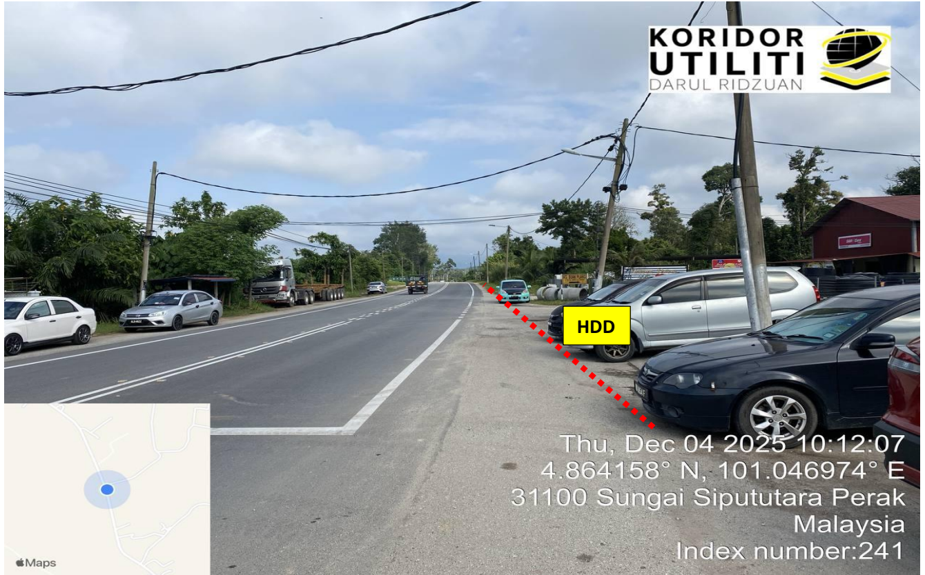
LOKASI DI JALAN FELDA LASAH JALAN MASUK (FT1145)
