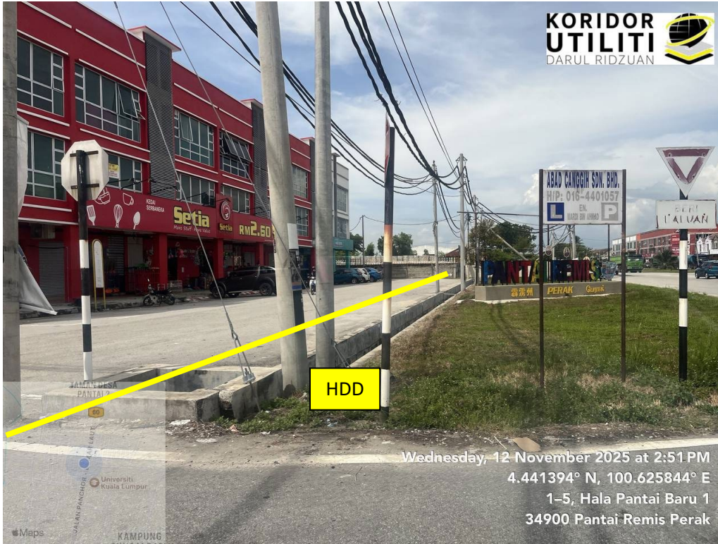
JAJARAN HDD DI HALA PANTAI BARU 1
