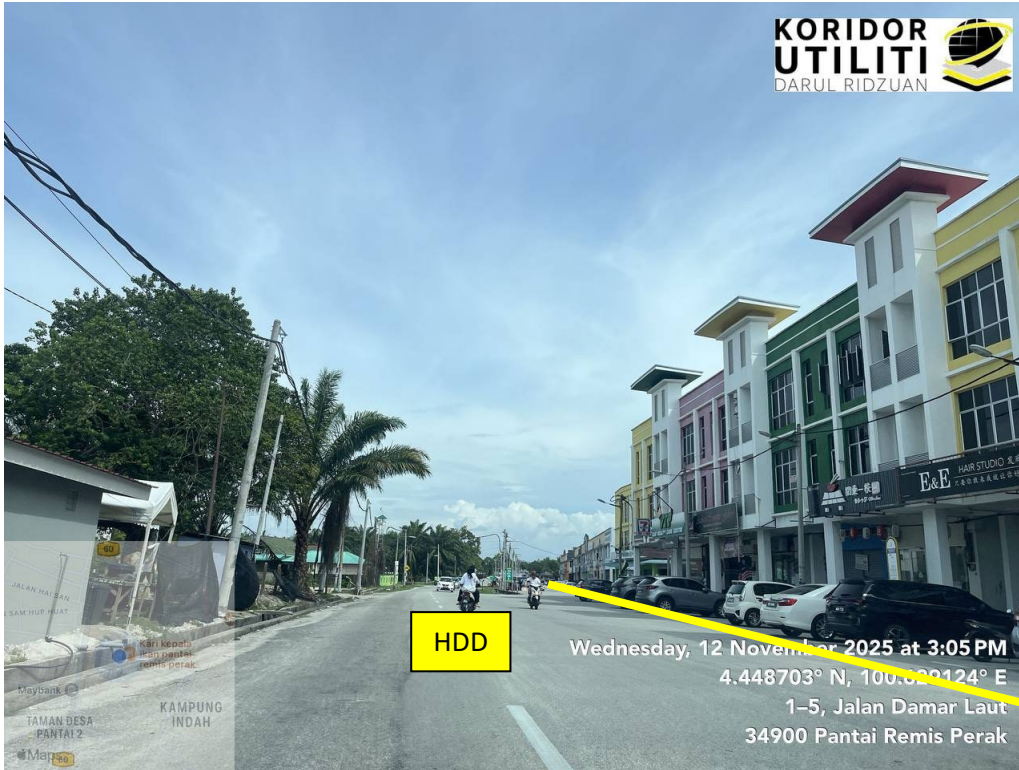
AJARAN HDD DI JALAN PANTAI JAYA 1
