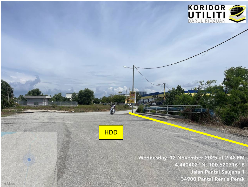
JAJARAN HDD DI JALAN PANTAI SAUJANA 1
