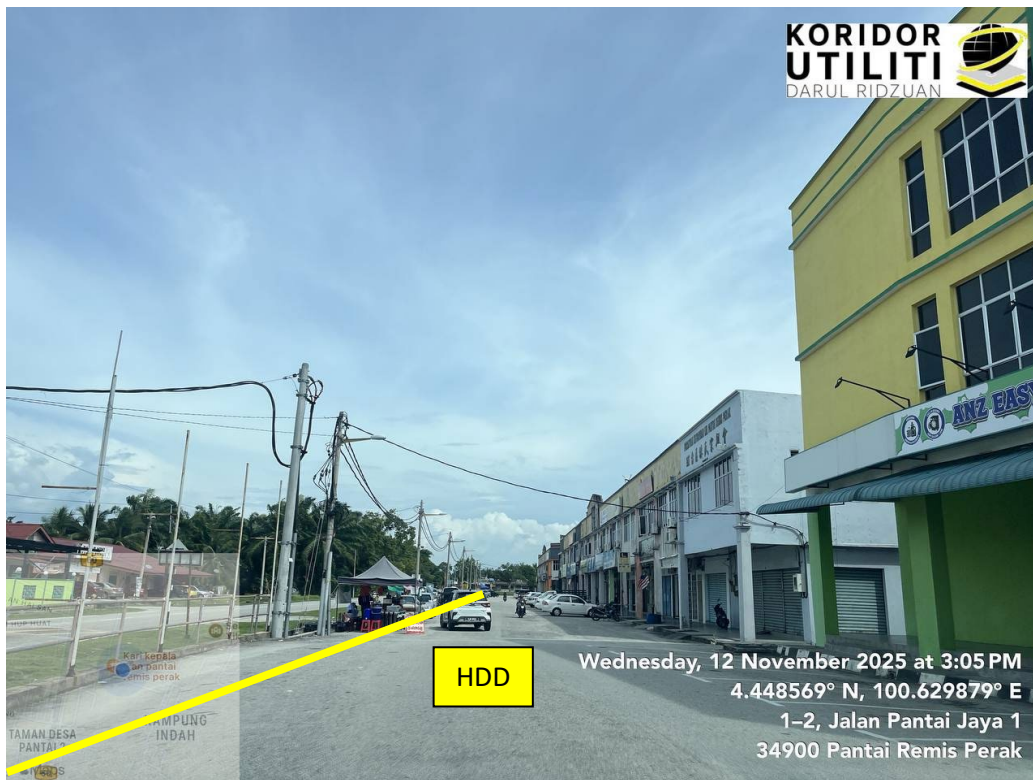
AJARAN HDD DI JALAN PANTAI JAYA 1
