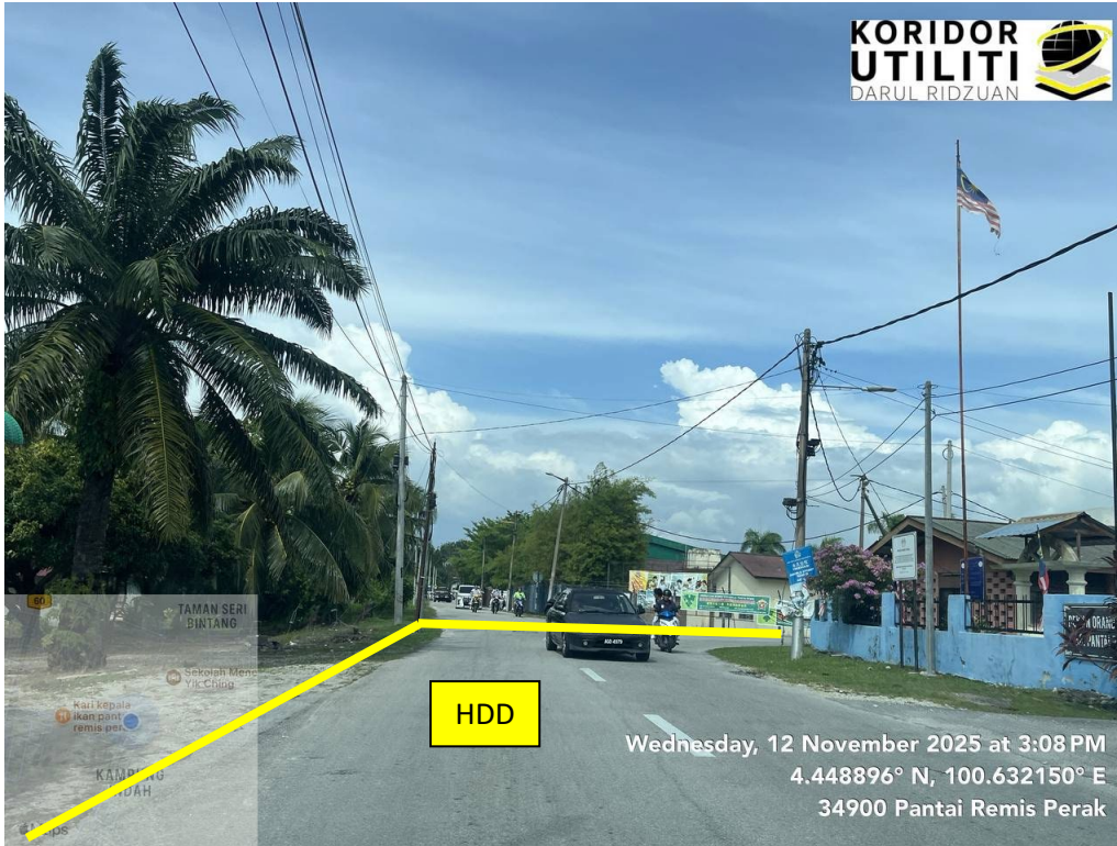
JAJARAN HDD DI JALAN RUMAH MURAH
