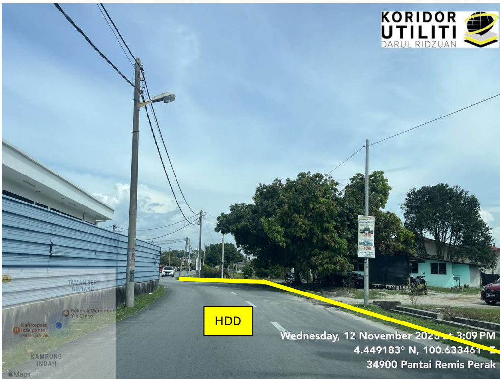
JAJARAN HDD DI JALAN TAMAN BINTANG
