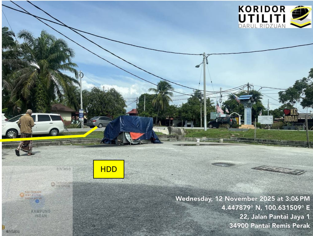
AJARAN HDD DI JALAN PANTAI JAYA 1
