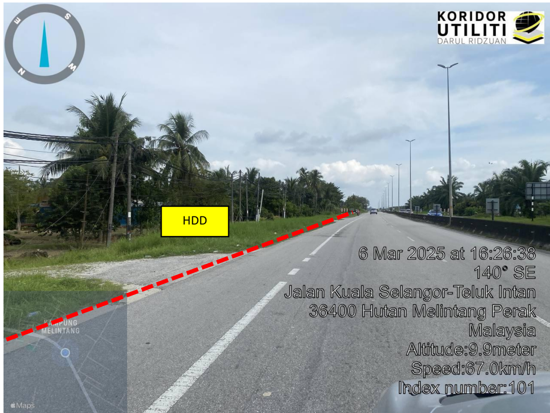
LOKASI DI JALAN KUALA SELANGOR-TELUK INTAN
