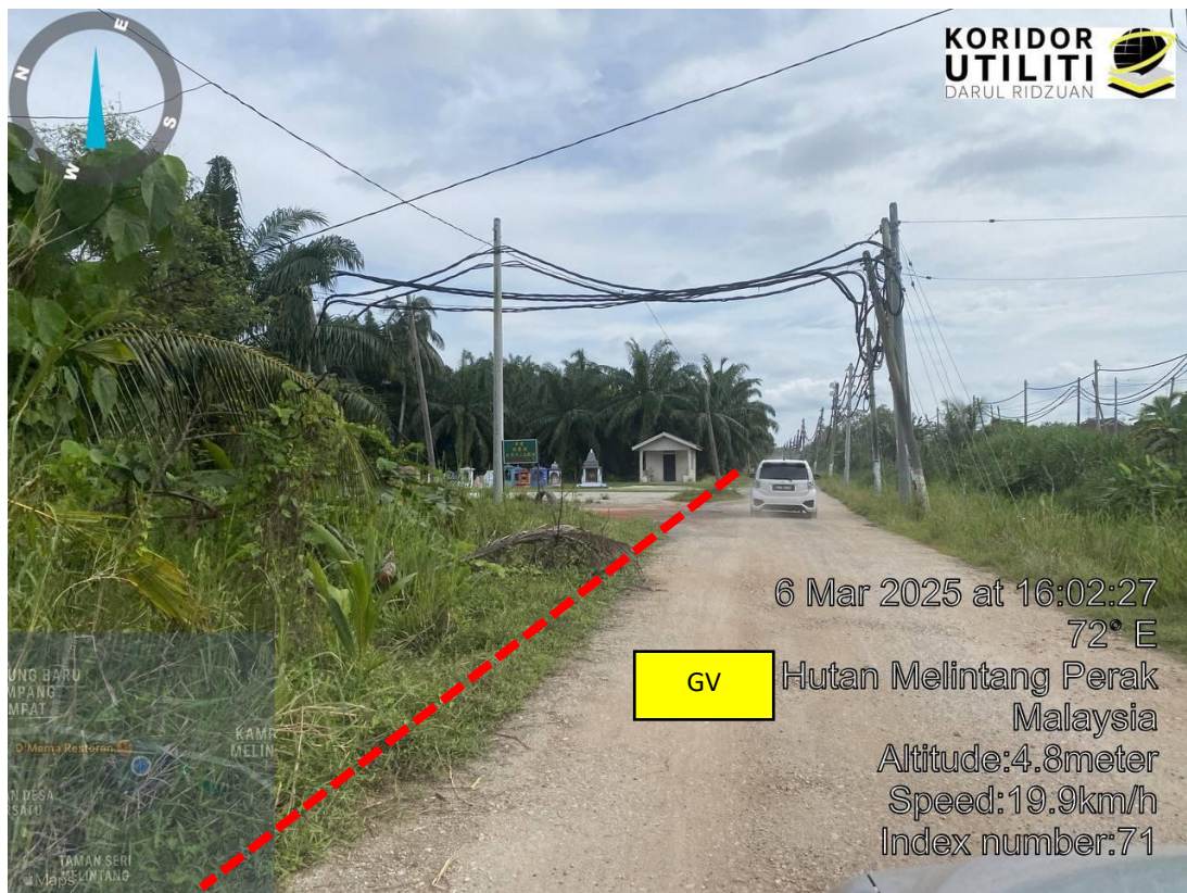
LOKASI DI JALAN KUALA SELANGOR-TELUK INTAN
