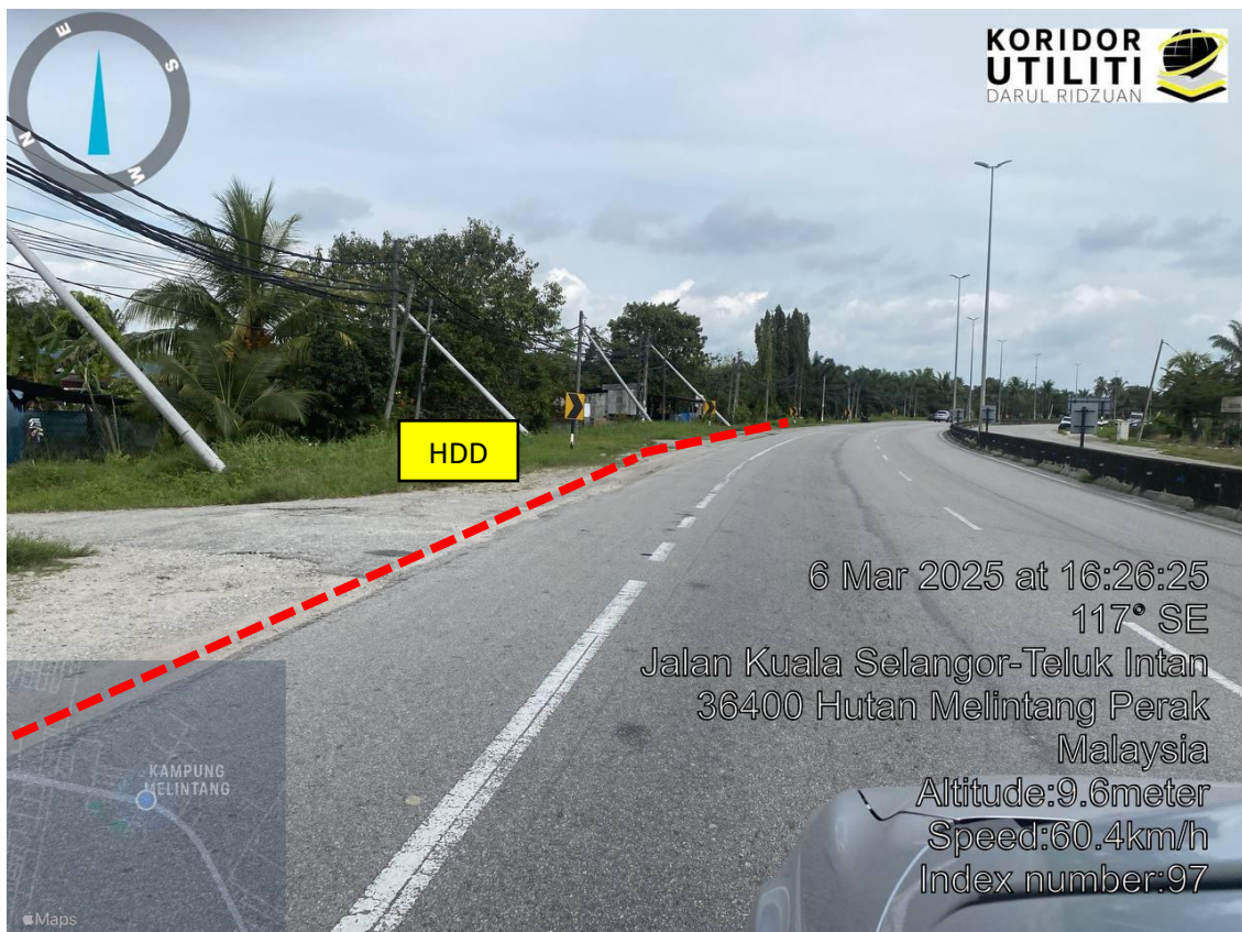
LOKASI DI JALAN KUALA SELANGOR-TELUK INTAN
