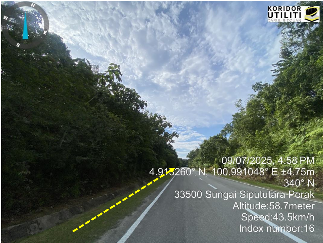
CADANGAN PENANAMAN TIANG DI JALAN JKR
