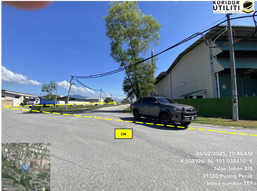
JAJARAN KERJA KOREKAN TERBUKA DI JALAN JOHAN 2
