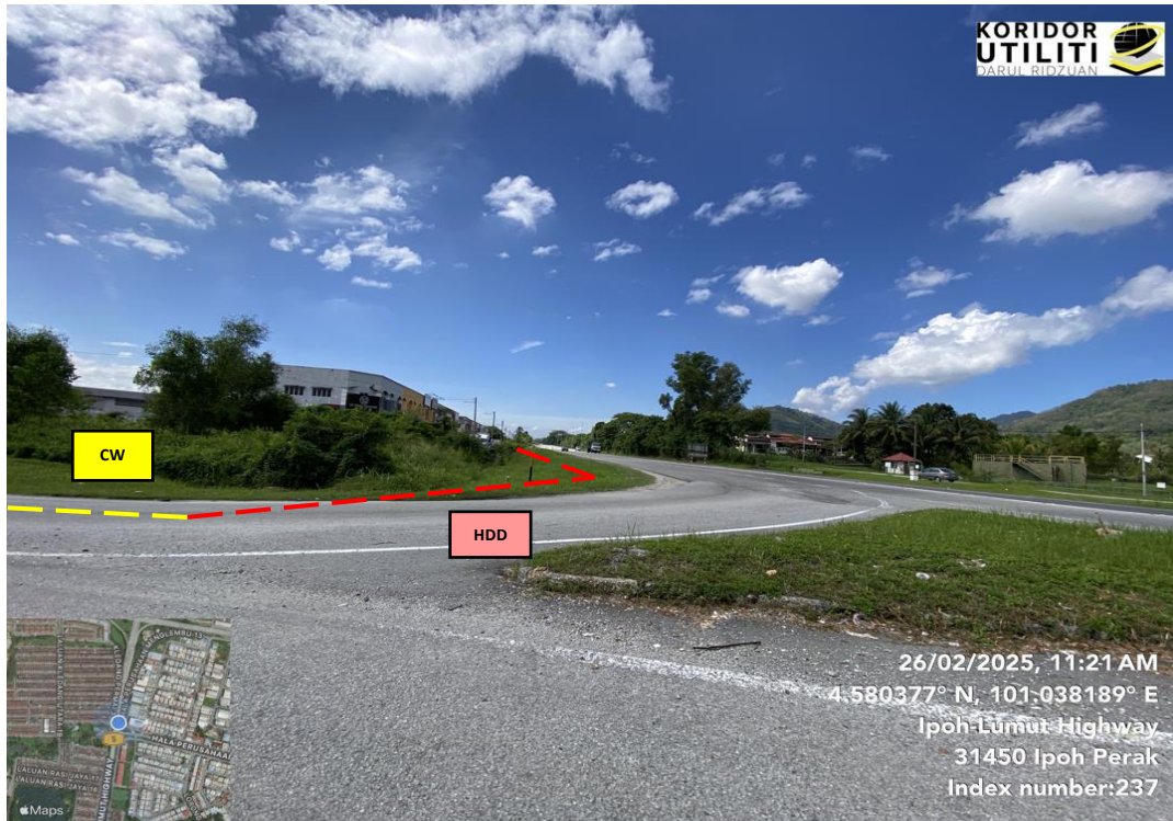
JAJARAN KERJA HDD DI JALAN JELAPANG – IPOH – AYER TAWAR (FT. 05) (Sambungan dari PPU KIM Menglembu ke PPU Lahat Mines Resort)
