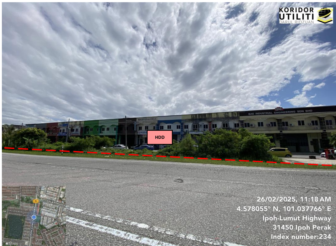
JAJARAN KERJA HDD DI JALAN JELAPANG – IPOH – AYER TAWAR (FT. 05) (Sambungan dari PPU KIM Menglembu ke PPU Lahat Mines Resort)
