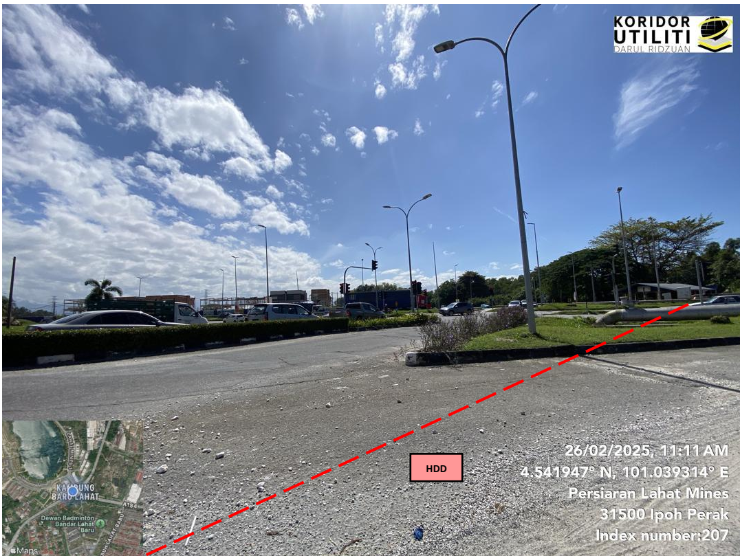
JAJARAN KERJA HDD DI JALAN LAHAT – PUSING (A2)
