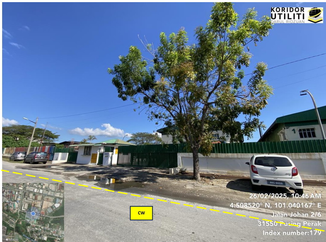
JAJARAN KERJA KOREKAN TERBUKA DI JALAN JOHAN 2/6
