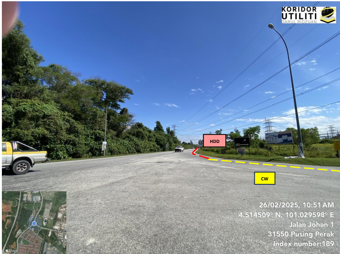
AJARAN KOREKAN TERBUKA DAN KERJA HDD DI JALAN LAHAT – PUSING (A2)
