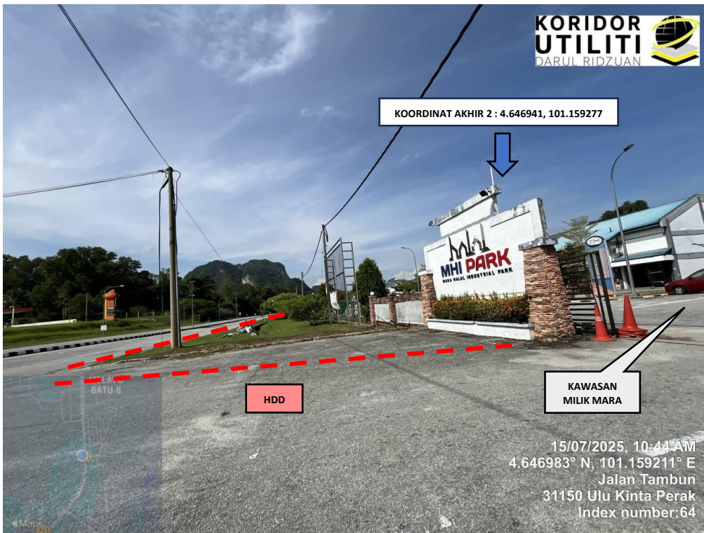
LOKASI KOORDINAT AKHIR KERJA HDD DI JALAN IPOH – TAMBUN (A013) (JALAN MILIK JKR) (Sambungan ke SSU KIK MARA di dalam kawasan milik MARA)
