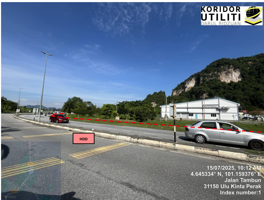
JAJARAN KERJA HDD DI JALAN IPOH – TAMBUN (A013) (JALAN MILIK JKR)
