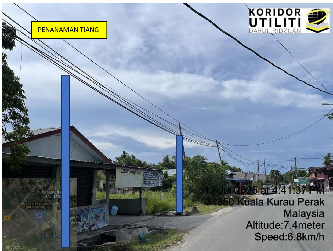
LOKASI DI JALAN KAMPUNG PARIT HAJI TAIB
