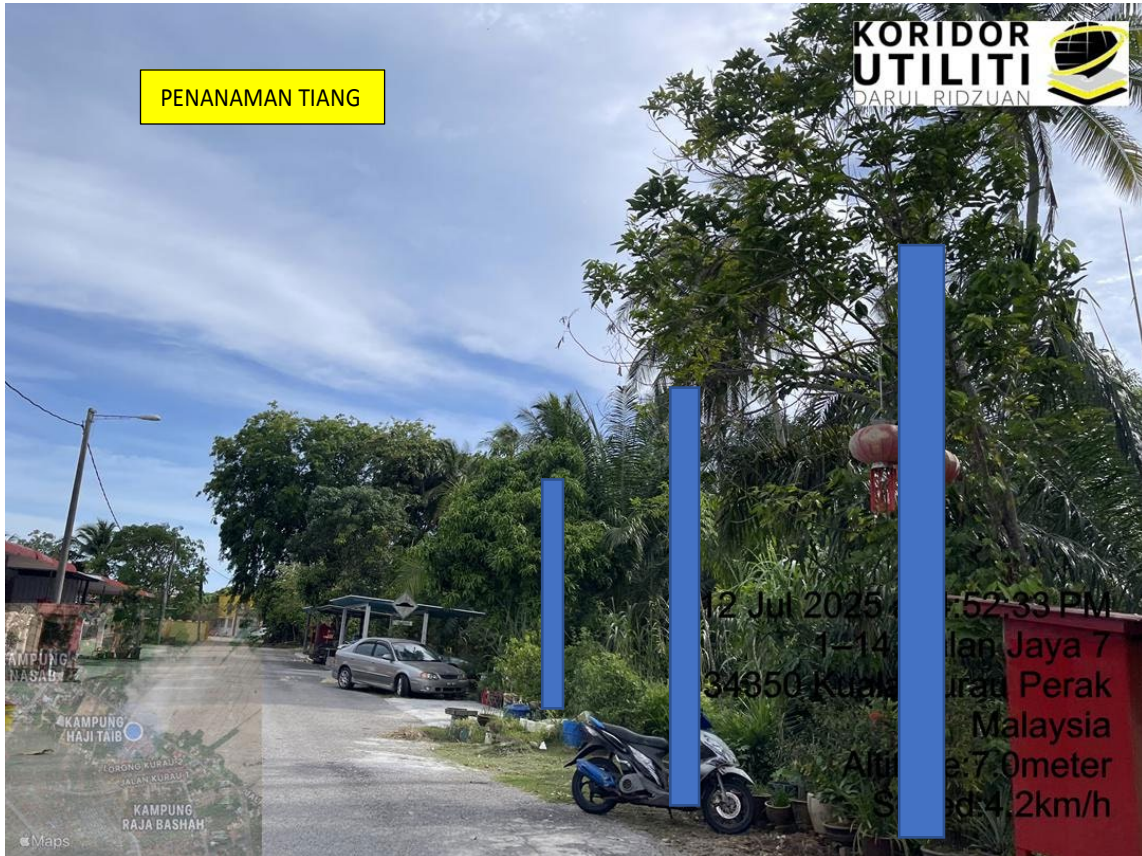
LOKASI DI JALAN TAMAN KURAU JAYA
