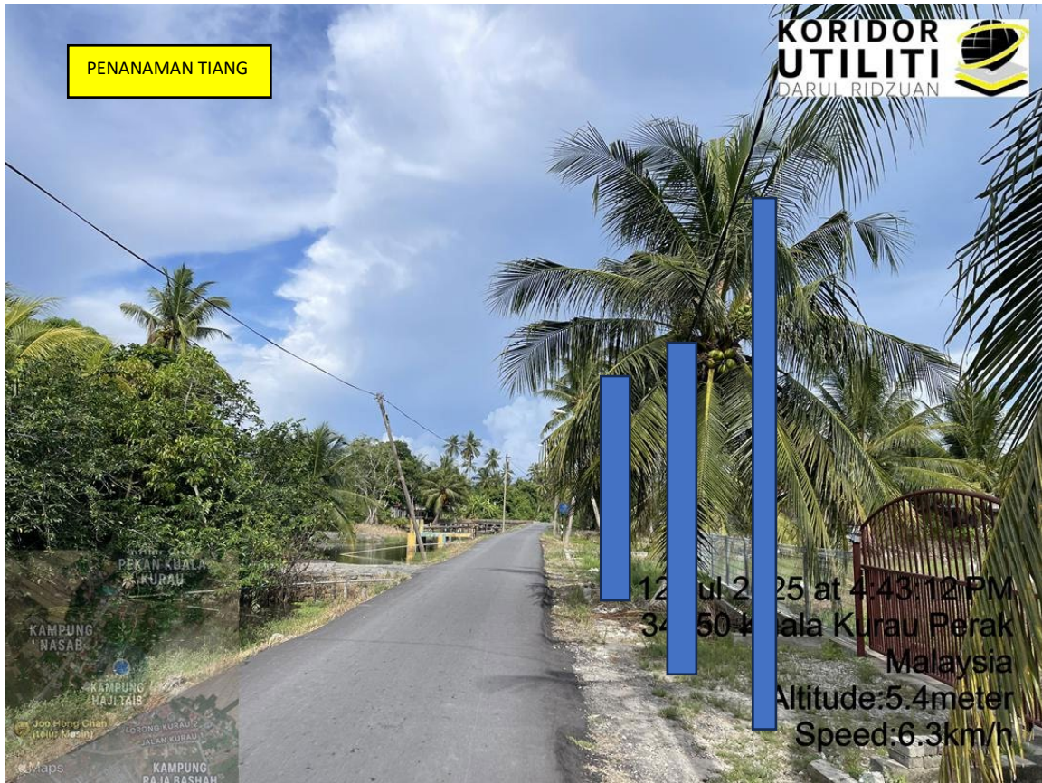
LOKASI DI JALAN KAMPUNG PARIT HAJI TAIB
