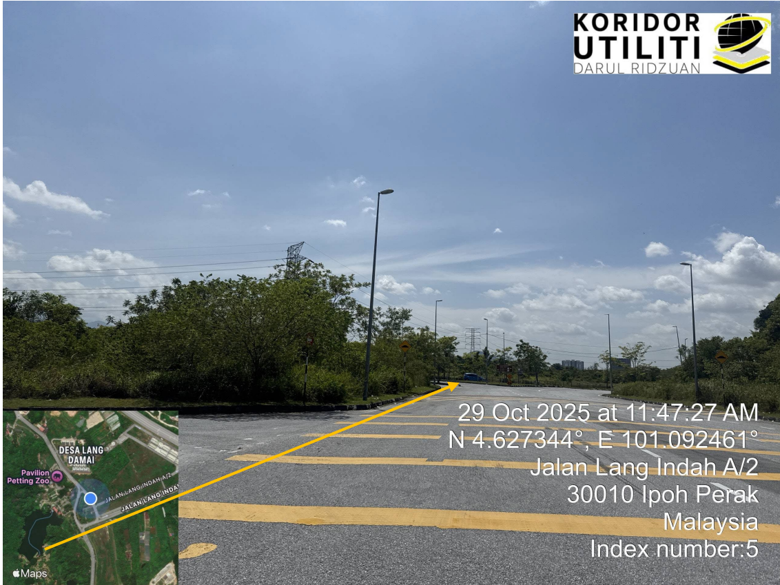
LOKASI DI JALAN LANG INDAH 1A
