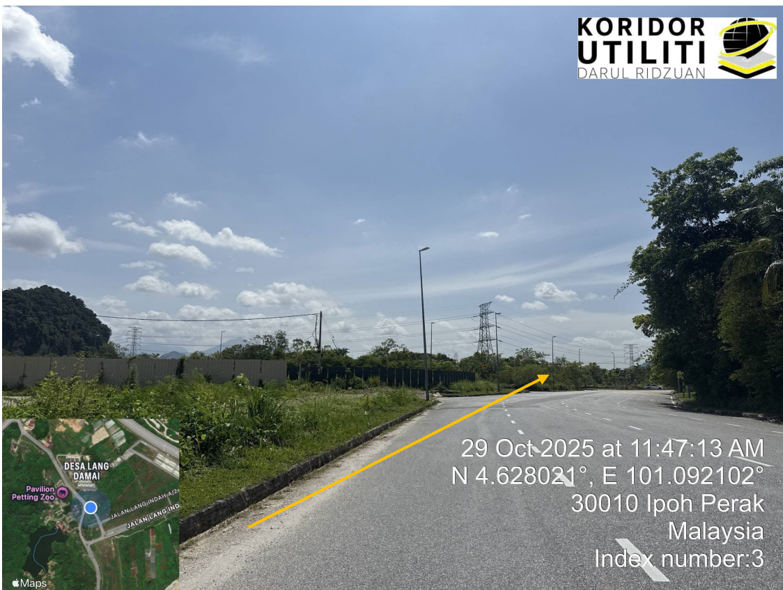
KOREKAN TERBUKA DI JALAN BERTURAP (CW)
