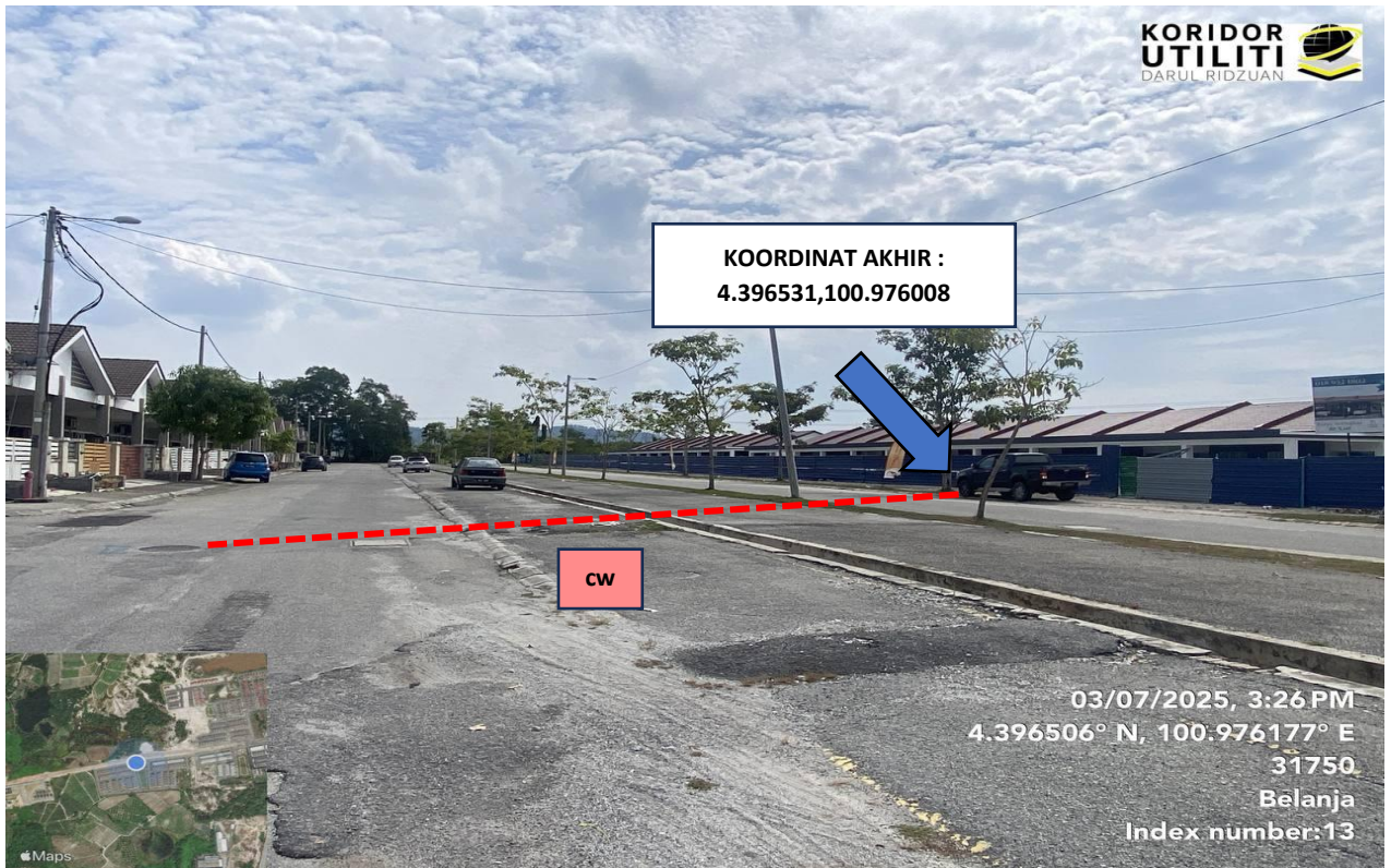
LOKASI KOORDINAT AKHIR KERJA-KERJA KOREKAN TERBUKA DI LALUAN TRONOH UNIVERSITI 1
