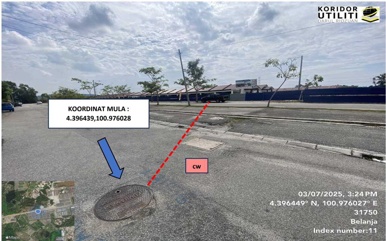
LOKASI KOORDINAT MULA KERJA-KERJA KOREKAN TERBUKA DI JALAN UTAMA TRONOH UNIVERSITI
