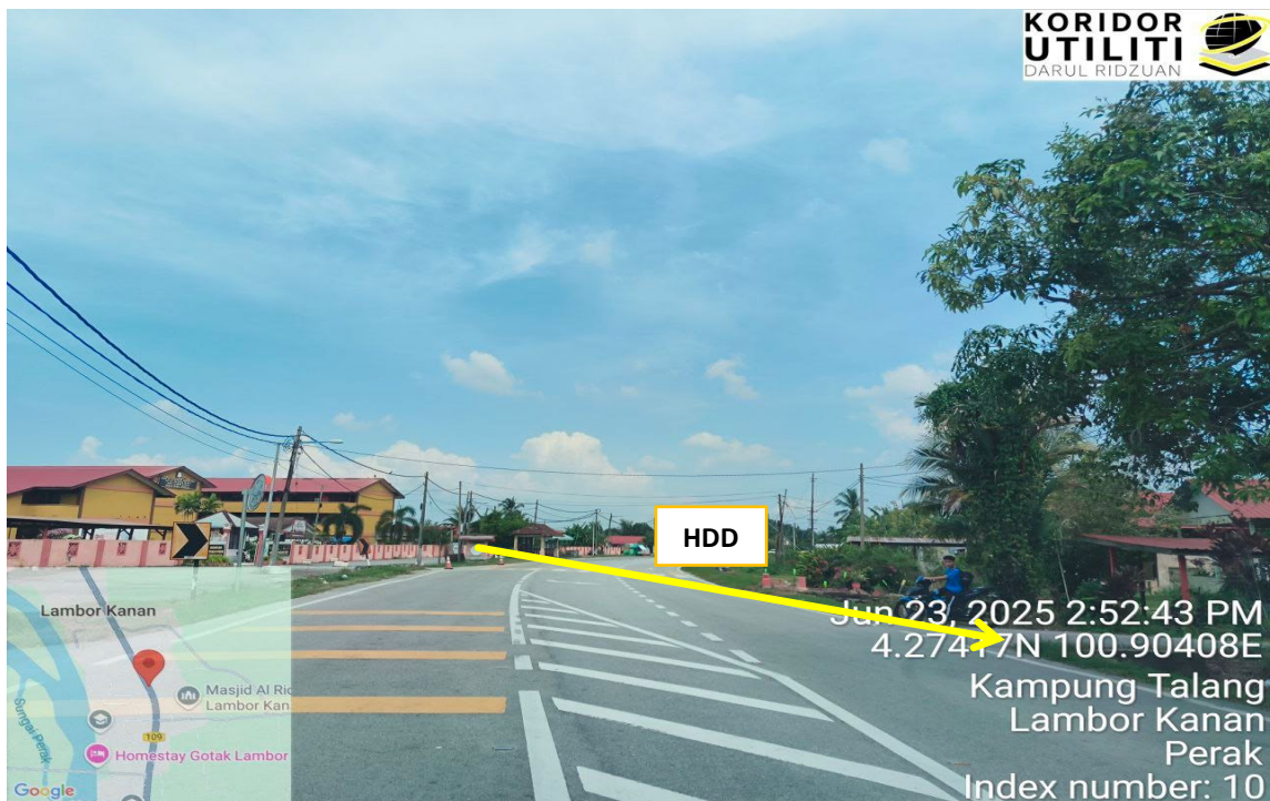
JALAN BOTA KANAN-KG GAJAH-TELUK INTAN (109)
