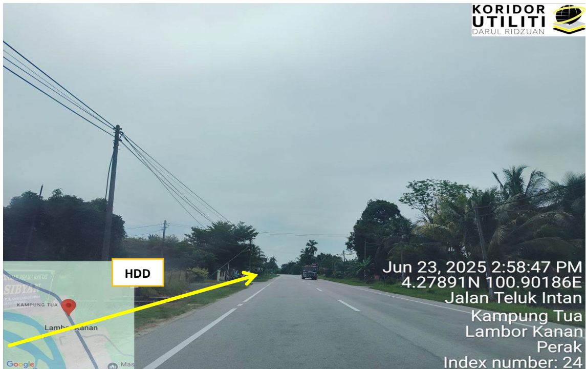
JALAN BOTA KANAN-KG GAJAH-TELUK INTAN (109)
