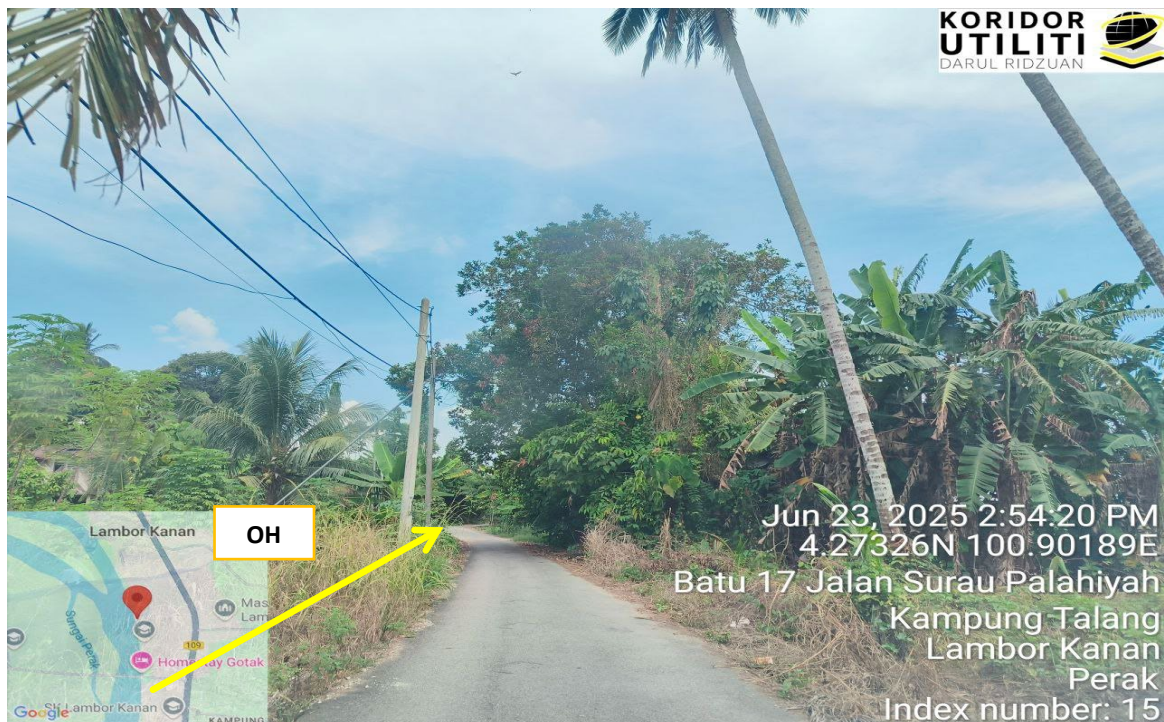
CADANGAN LALUAN BAGI KERJA PENANAMAN TIANG
