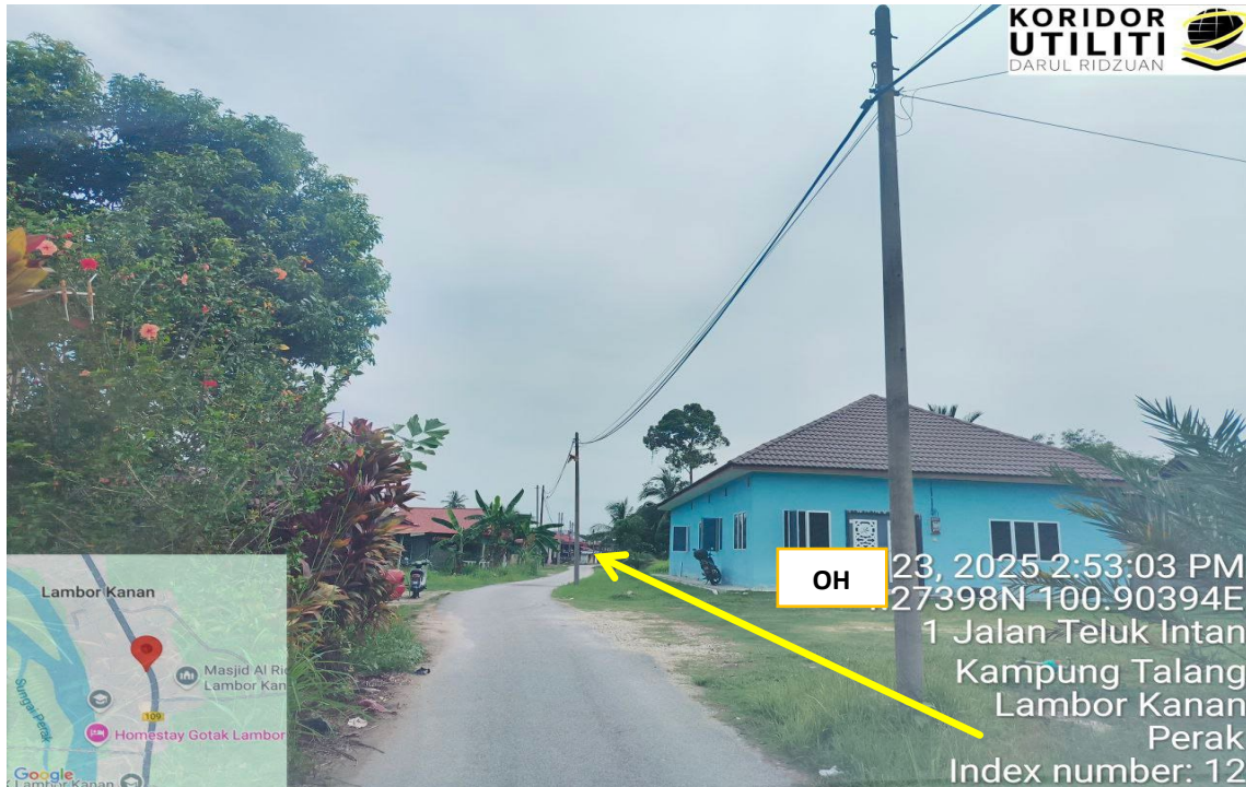
CADANGAN LALUAN BAGI KERJA PENANAMAN TIANG
