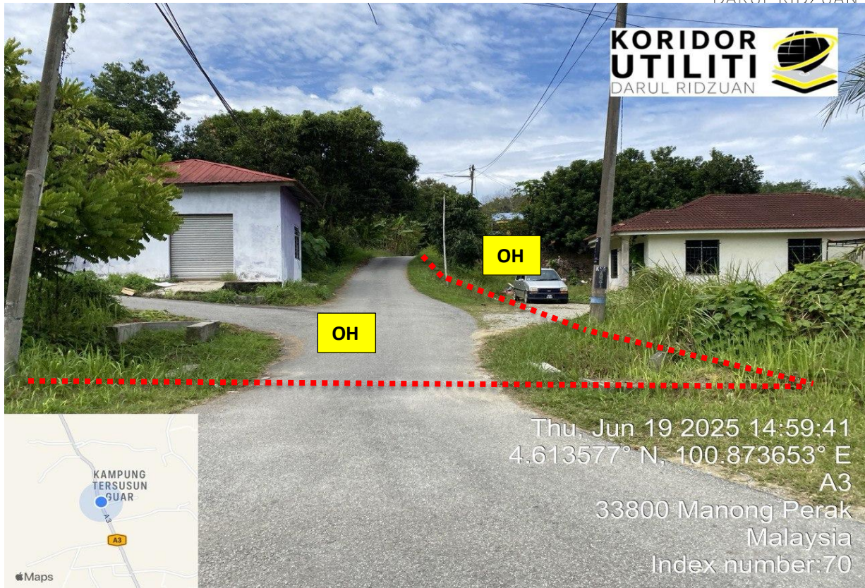
LOKASI DI JAJARAN PEMASANGAN UTILITI
