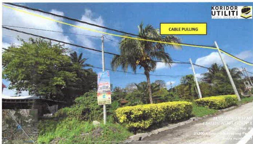
JAJARAN CABLE PULLING JALAN MILIK JKR : JALAN SIMPANG PULAI - LAHAT (FT. 3150)
