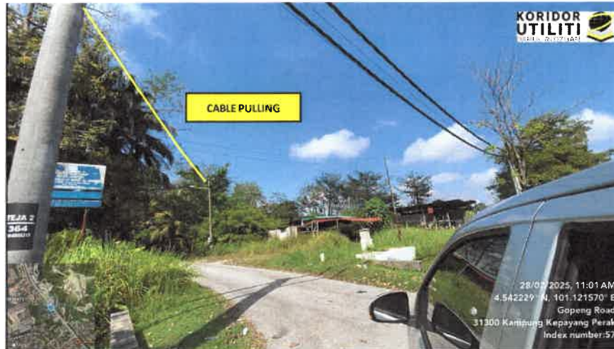
JAJARAN CABLE PULLING DI JALAN SIMPANG PULAI - LAHAT KE JALAN HAJI BUYONG BODEEN JALAN MILIK JKR : JALAN SIMPANG PULAI - LAHAT (FT. 3150) JALAN MILIK MBI : JALAN HAJI BUYONG BODEEN
