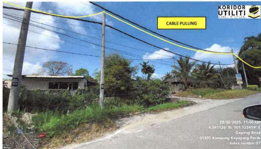
KAJANGAN KABEL PULLING JALAN MILIK JKR : JALAN SIMPANG PULAI - LAHAT (FT. 3150)
