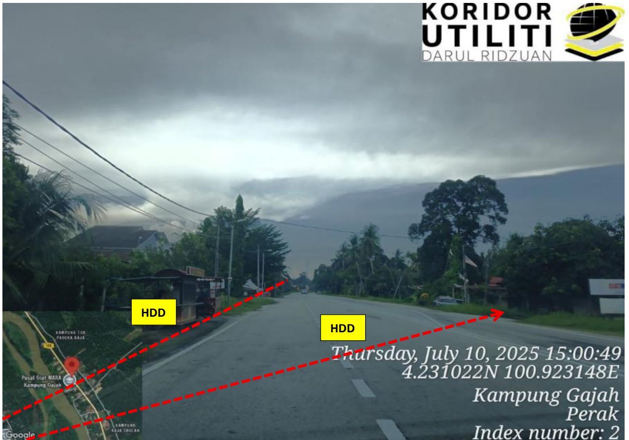
JALAN BOTA KANAN – KG GAJAH – TELUK INTAN (109)
