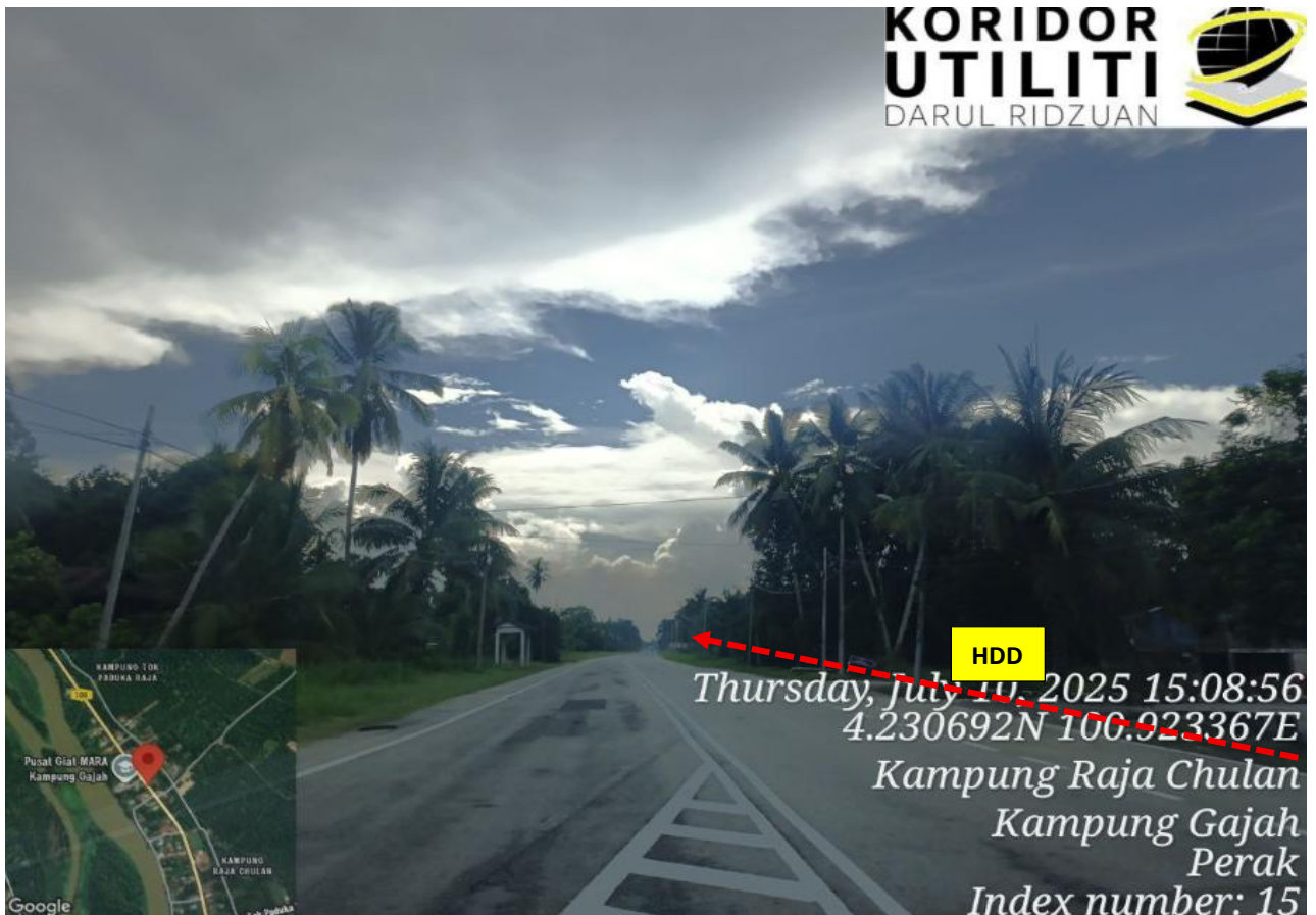
JALAN BOTA KANAN – KG GAJAH – TELUK INTAN (109)
