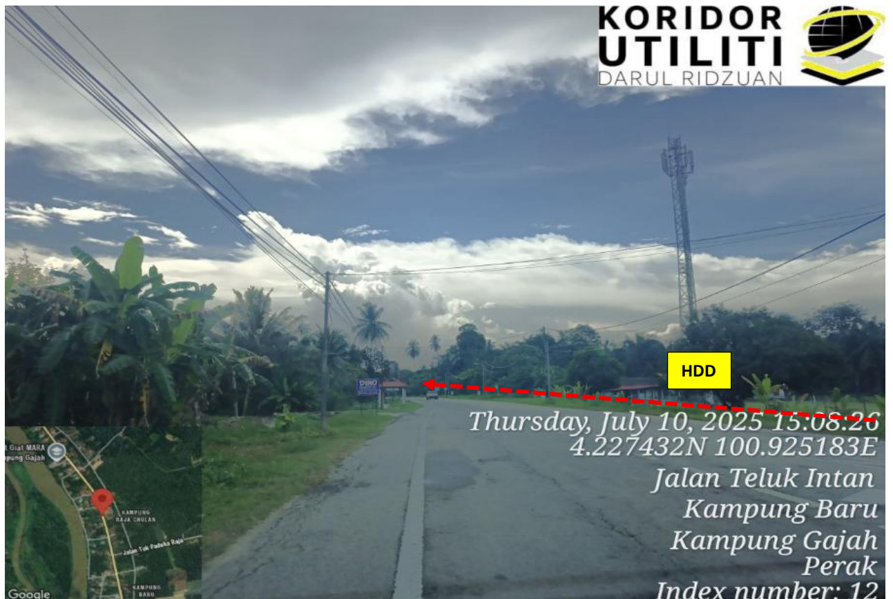
JALAN BOTA KANAN – KG GAJAH – TELUK INTAN (109)
