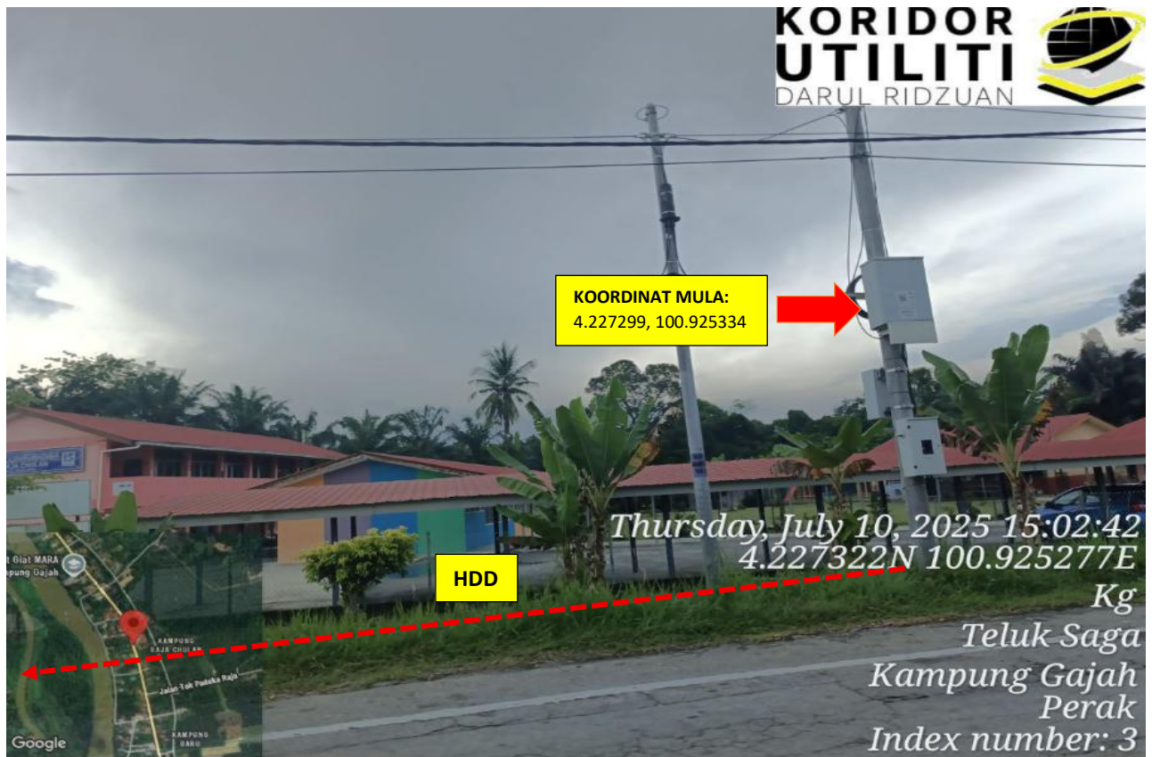
JALAN BOTA KANAN – KG GAJAH – TELUK INTAN (109)
