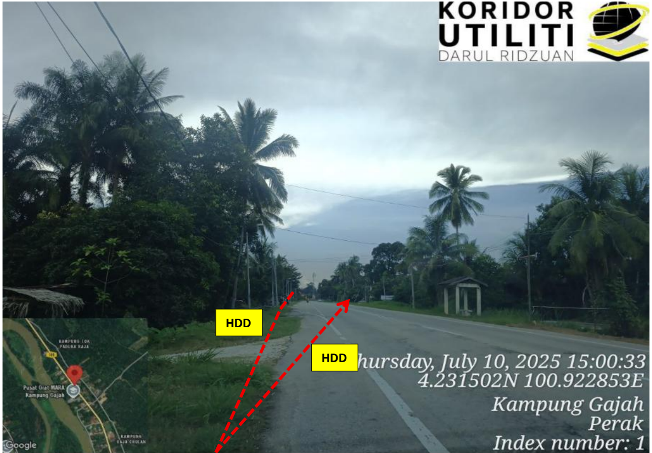
JALAN BOTA KANAN – KG GAJAH – TELUK INTAN (109)
