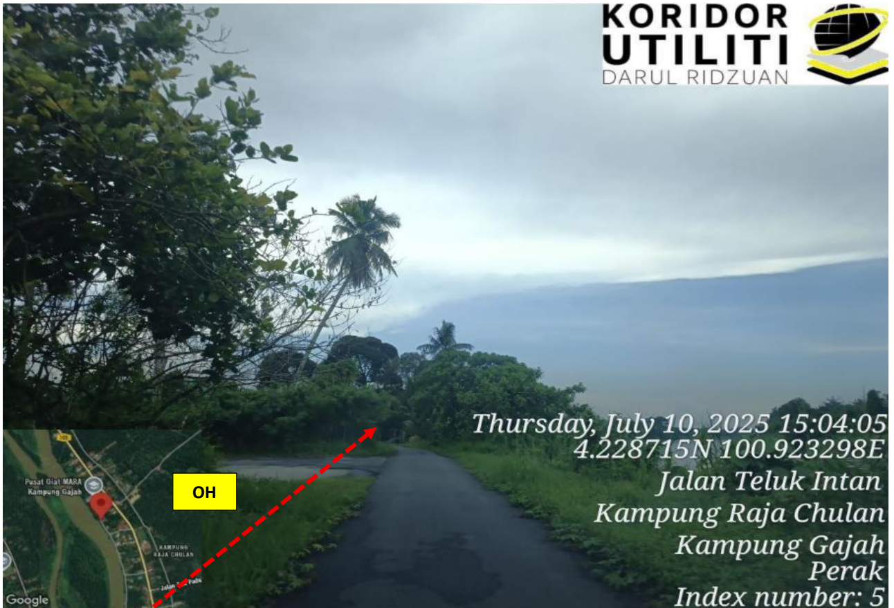
JALAN SURAU IHSANIAH
