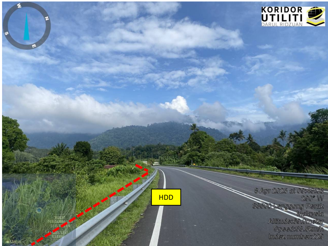
LOKASI DI JALAN TASEK RABAN
