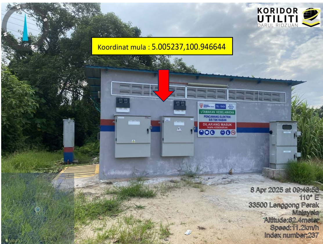
LOKASI DI JALAN TASEK RABAN
