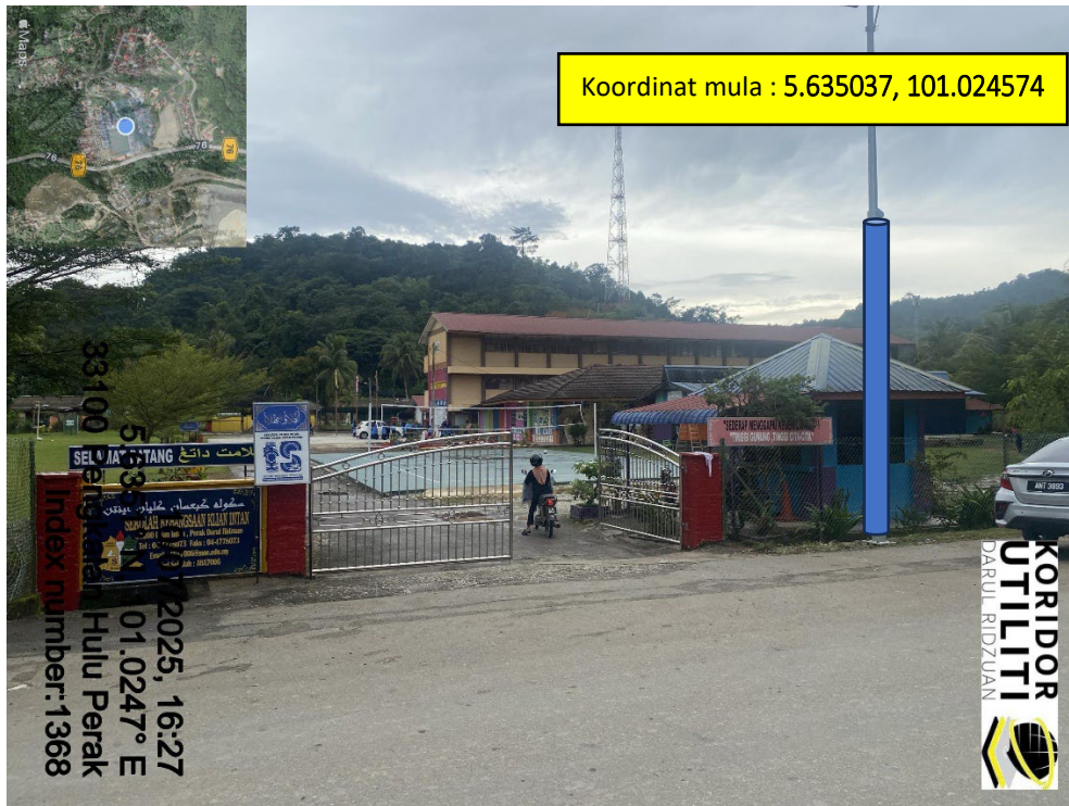
LOKASI DI JALAN SK KLIAN INTAN
