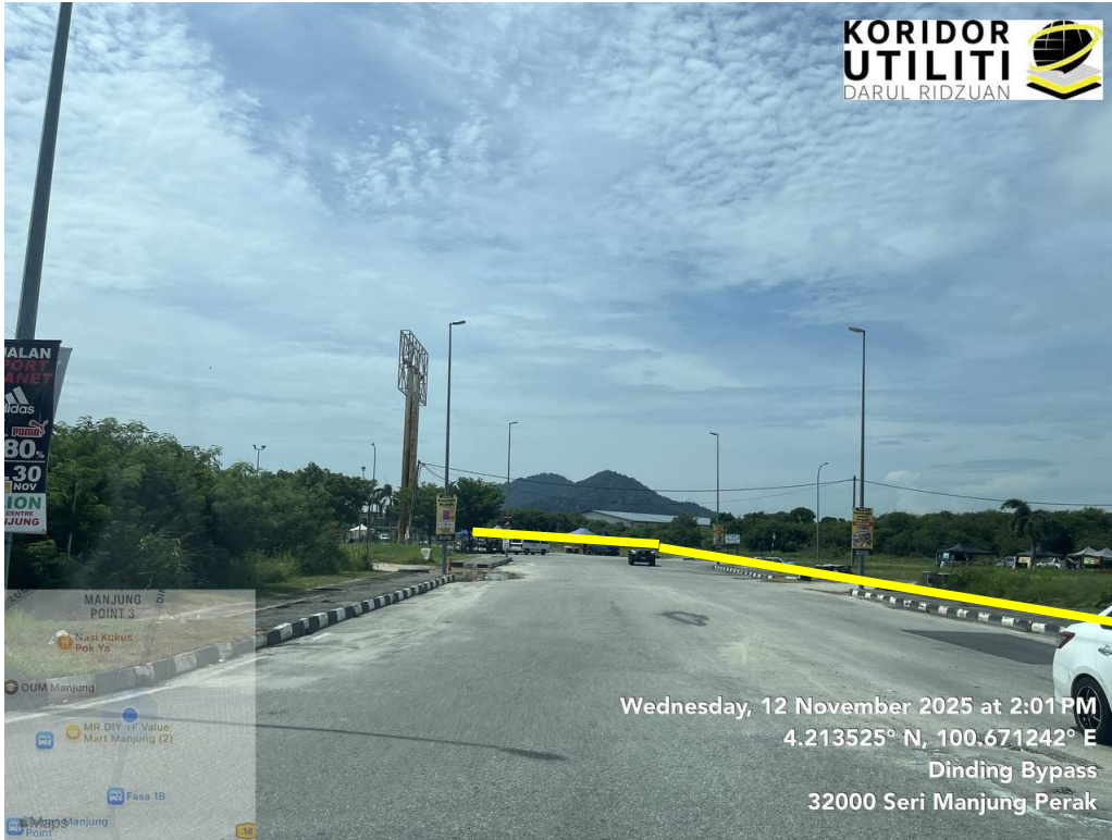
JAJARAN HDD DI JALAN PPMP 4
