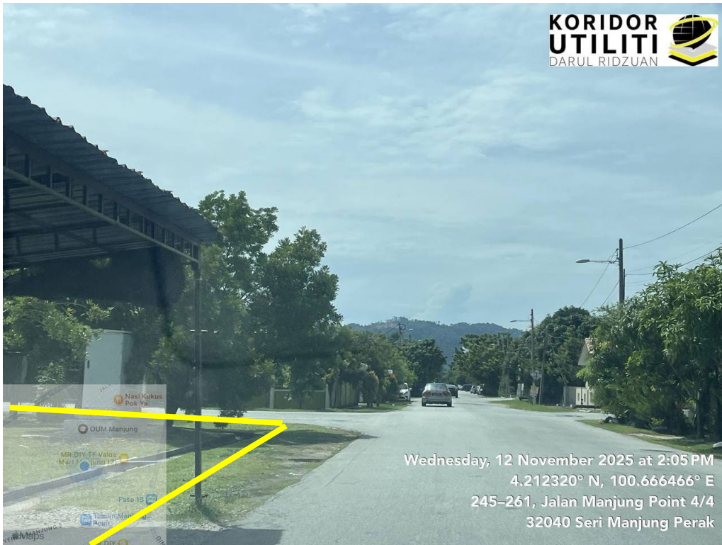
JAJARAN HDD DI LORONG MANJUNG POINT 4/4
