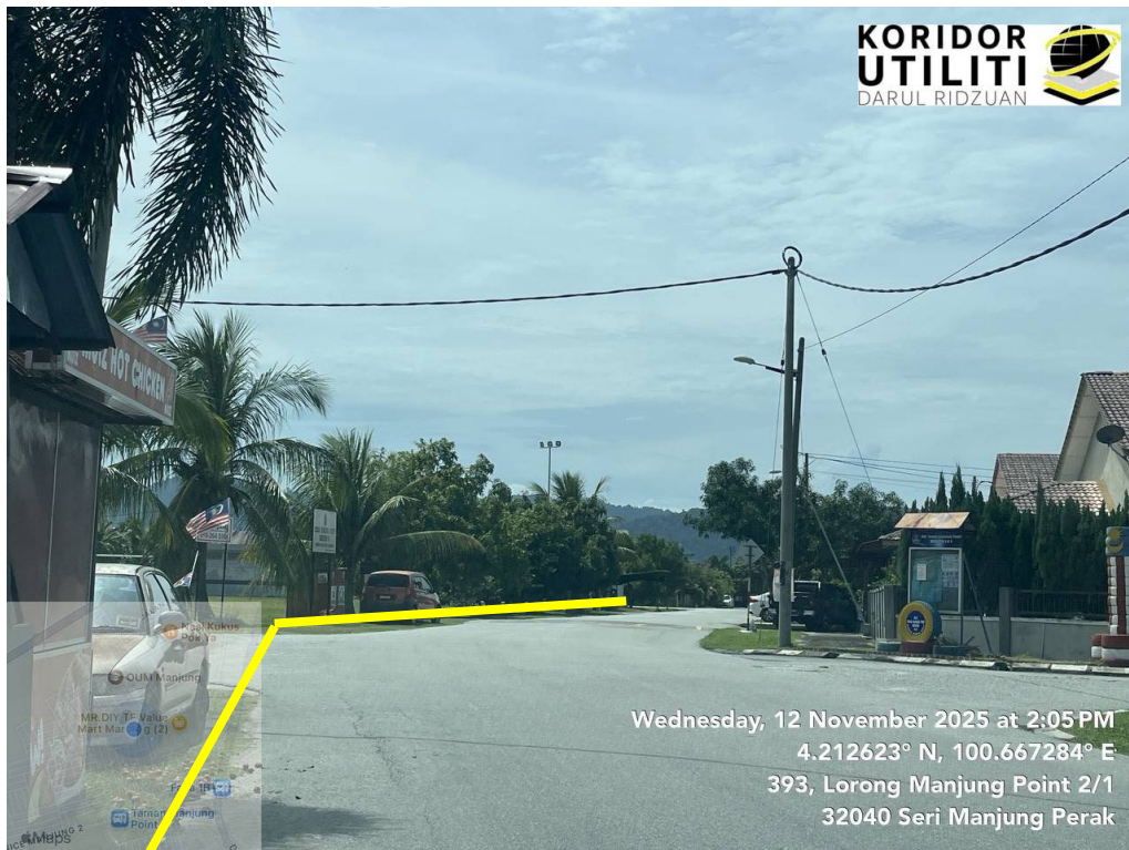
AJARAN HDD DI LORONG MANJUNG POINT 2/1
