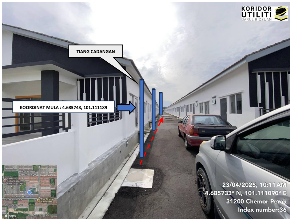
LOKASI KOORDINAT MULA KERJA PENANAMAN TIANG DAN PENARIKAN KABEL DI JALAN PUTRA D/11 (LORONG BELAKANG) – (Tapping from existing manhole)
