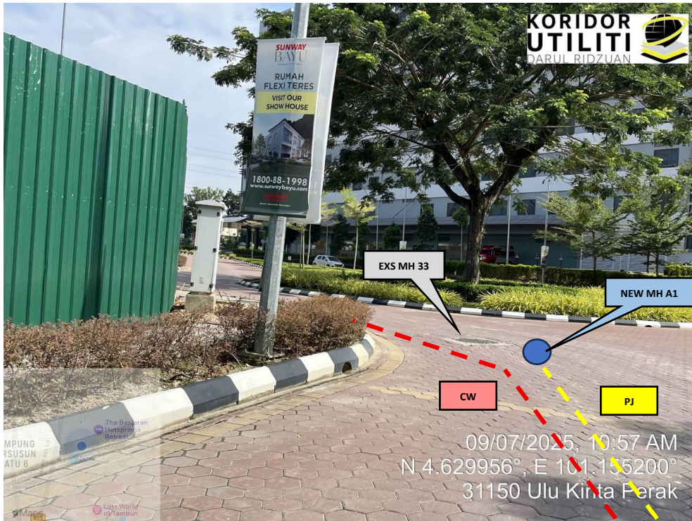
JAJARAN KERJA KOREKAN TERBUKA DAN PIPE JACKING DI JALAN SUNWAY ONSEN 2 (JALAN PERSENDIRIAN)
