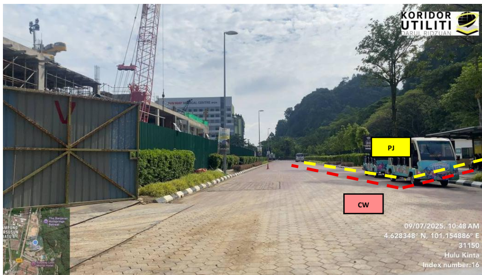
JAJARAN KERJA KOREKAN TERBUKA DAN PIPE JACKING DI JALAN SUNWAY ONSEN 2 (JALAN PERSENDIRIAN)
