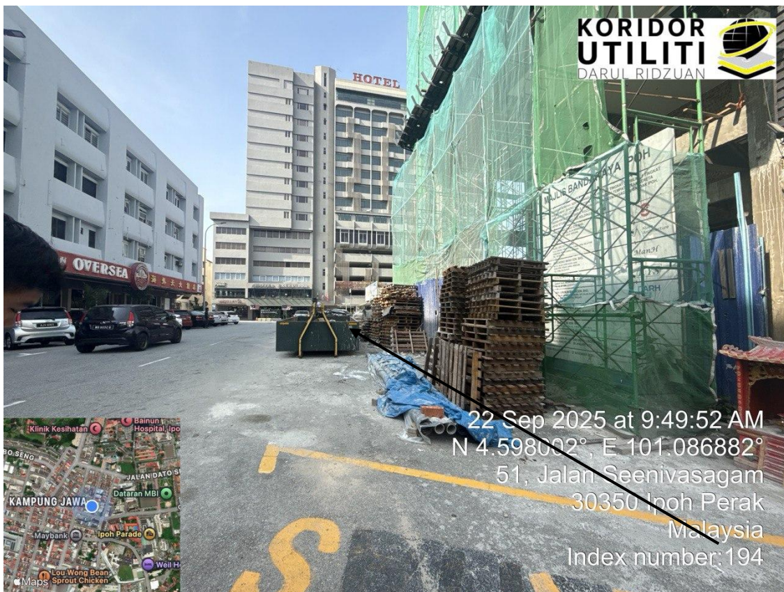
KOREKAN TERBUKA DI JALAN SEENIVASAGAM
