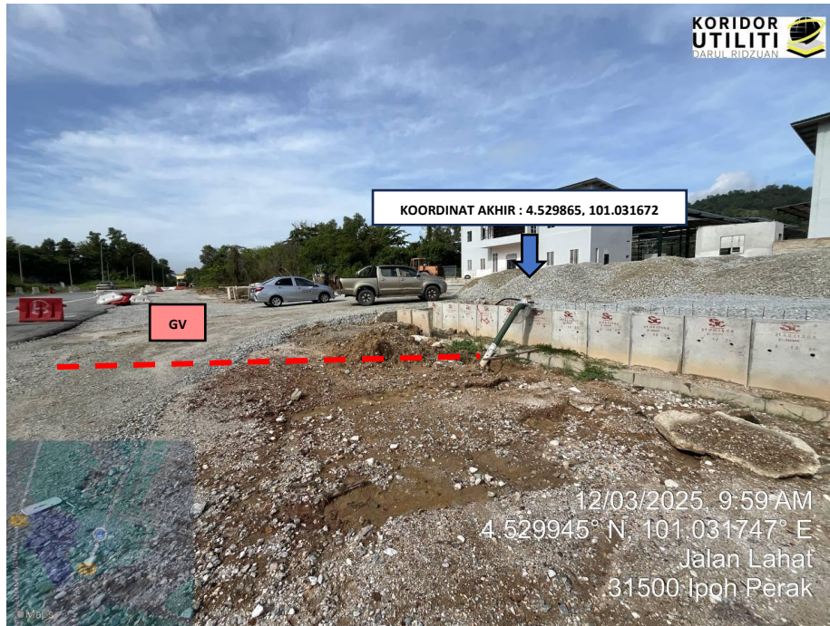
LOKASI AKHIR KOREKAN TERBUKA JALAN TIDAK BERTURAP DI JALAN LAHAT – PUSING (A2)
